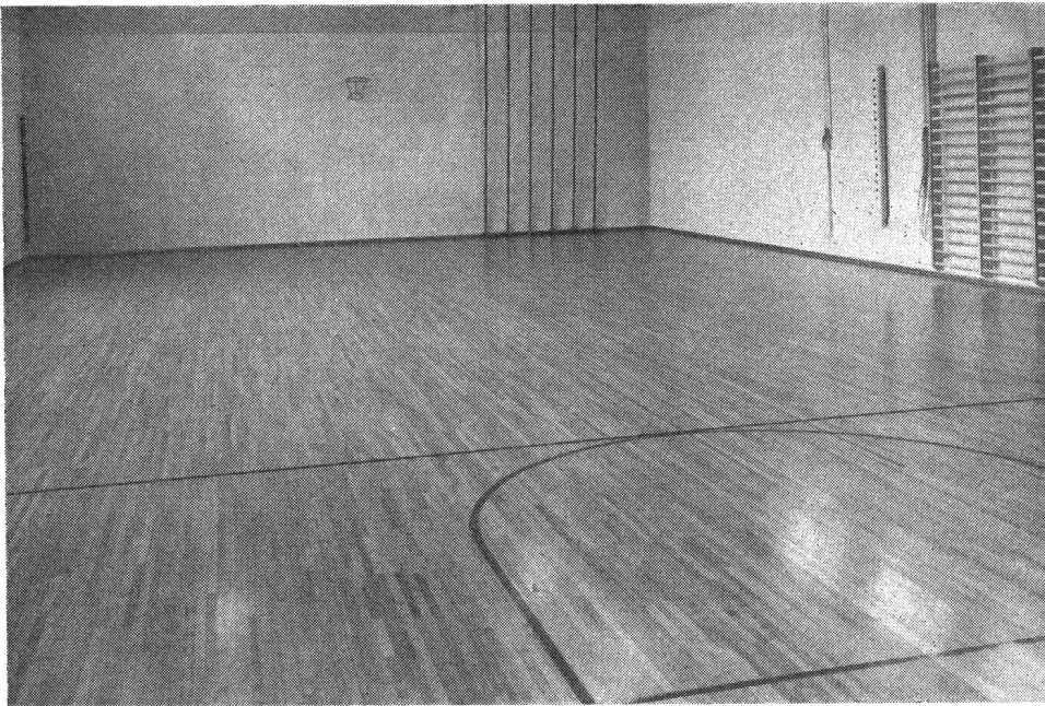
Abb. 2 Turnhallenboden mit HAMA-Riemen in Eschenholz, hell und sauber wirkend. (Photo: R. M. Büteler, Kriens-Luzern)
