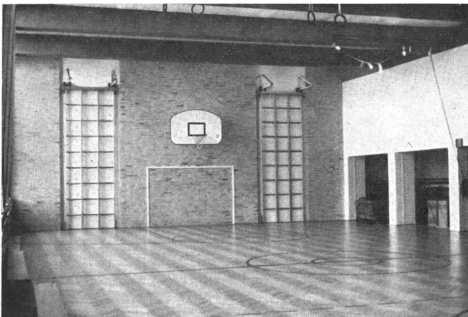
Abb. 3 «Ballsichere» Stirnseiten in Sichtbackstein-Mauerwerk, auch Vormauerwerkstein genannt. Rechts im Bild, Garagen-Kipptor als Zu- gang zum Geräteraum, geöffnet
