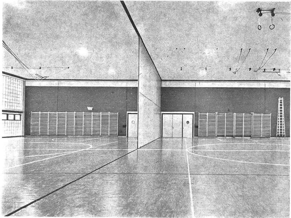
Trennwand. Bei der Ausführung der Fenster musste berücksichtigt werden, dass die Spielrichtung bei geöffneter Trennwand eine andere ist. Mit Glasbausteinen, d. h. richtig gewählten Funktionssteinen konnte das Problem jedoch relativ leicht gelöst werden, sind diese doch absolut ballsicher und auch weitgehend blendungsfrei. Die Trennwand der vorgenannten Halle besteht aus Aluminiumtafeln, die leicht von Hand an eine Seitenwand geschoben werden kann. Die einzel-
