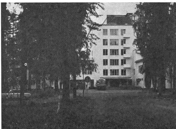
Hauptgebäude der finnischen Sportschule
