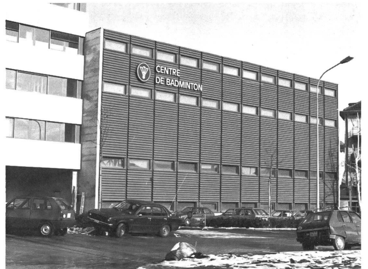
Aussenansicht des Badminton-Zentrums Prilly.
