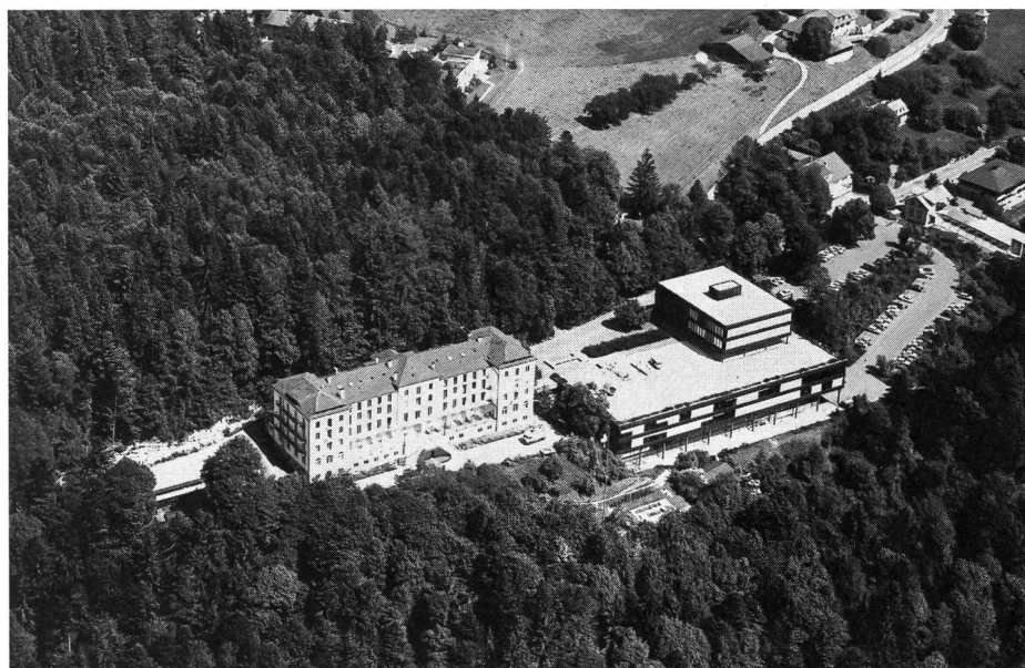
Links das Unterakunftsgebäude (ehem. Kurhaus), rechts das Schul- und Verwaltungsgebäude ESSM.
