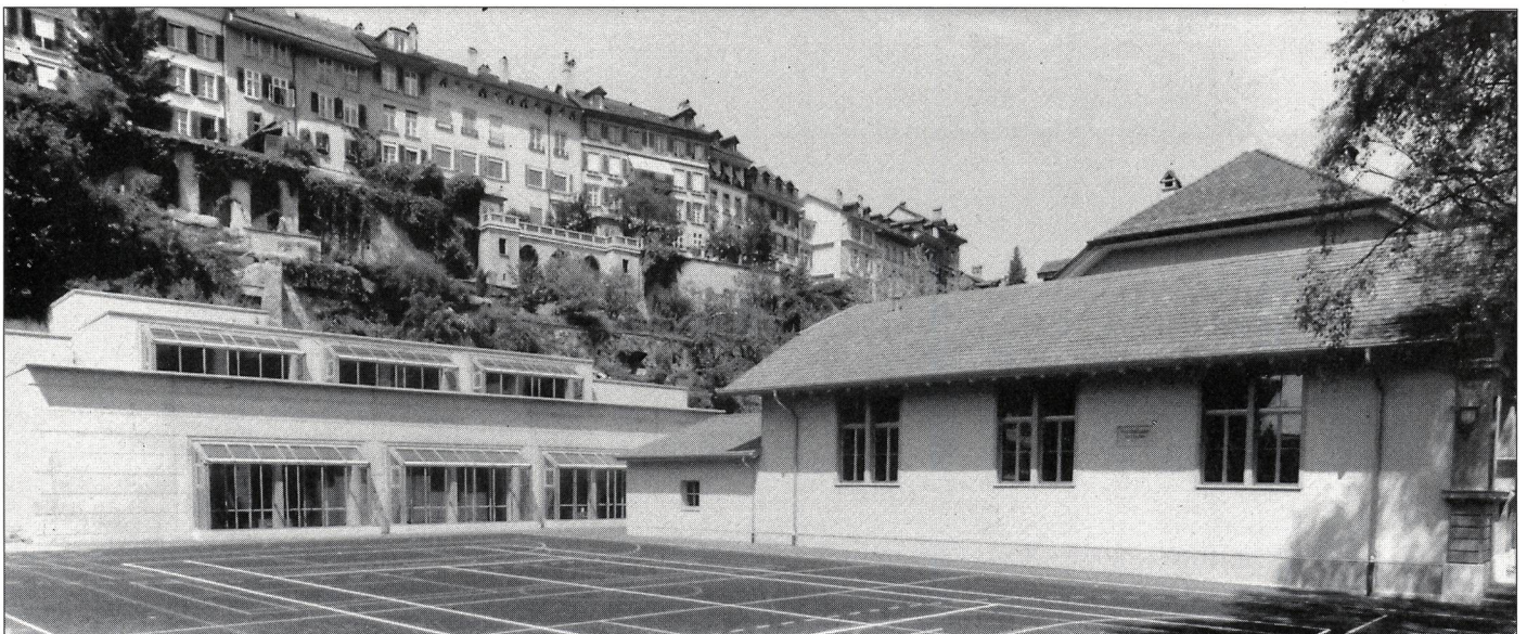
Turnhalle Matte, Bern: Rechts die alte, sanierte Halle, links die im Hang versenkte neue.
