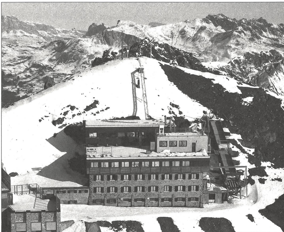
Das SLF-Forschungsgebäude Weissfluhjoch/Davos auf 2670 m ü.M.
