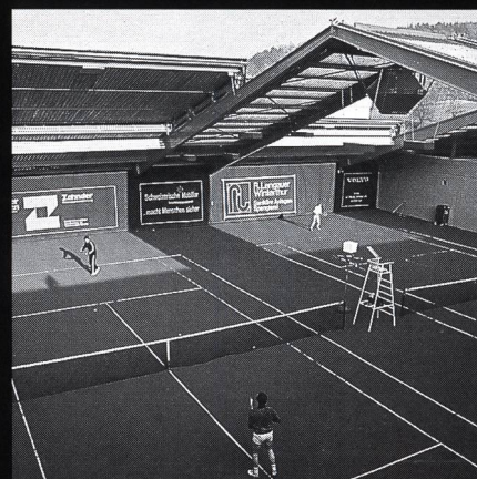
AGOB-Schiebedachhallen Tenniscenter Grüze Winterthur
