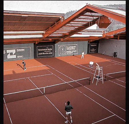
AGOB-Schiebedachhallen Tenniscenter Grüze Winterthur
