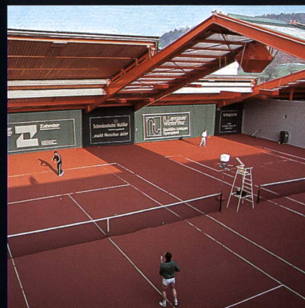
AGOB-Schiebedachhallen Tenniscenter Grütze Winterthur
