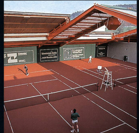
AGOB-Schiebedachhallen Tenniscenter Grütze Winterthur
