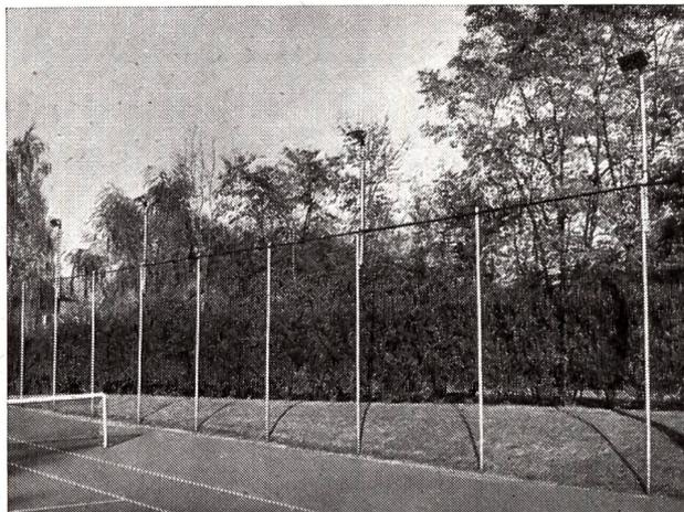
Aspect des 4 projecteurs de iode montés latéralement, adaptés à la hauteur normale des grilles, pour l'éclairage d'une place à deux terrains.
