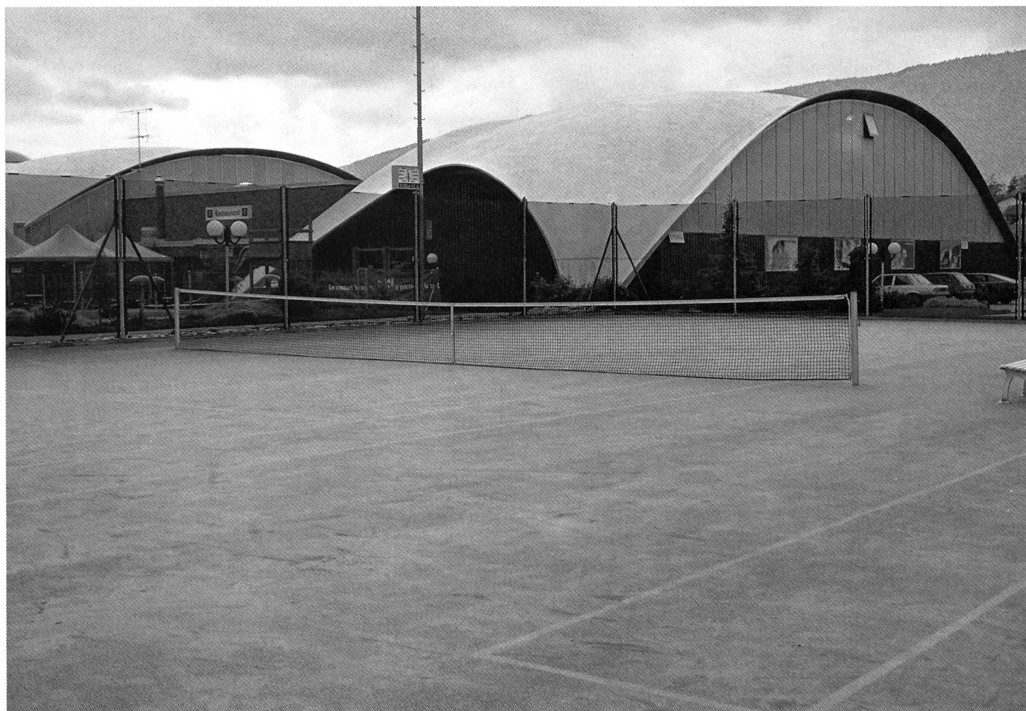
Gazon synthétique sablé du CIS de Marin (NE).
