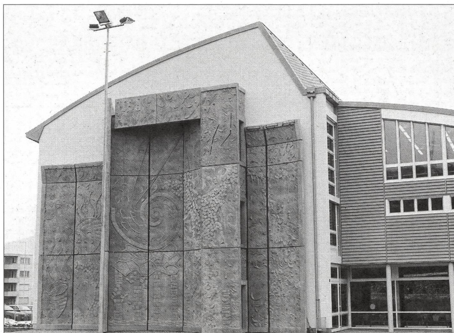
Mur d'escalade à Liestal.
