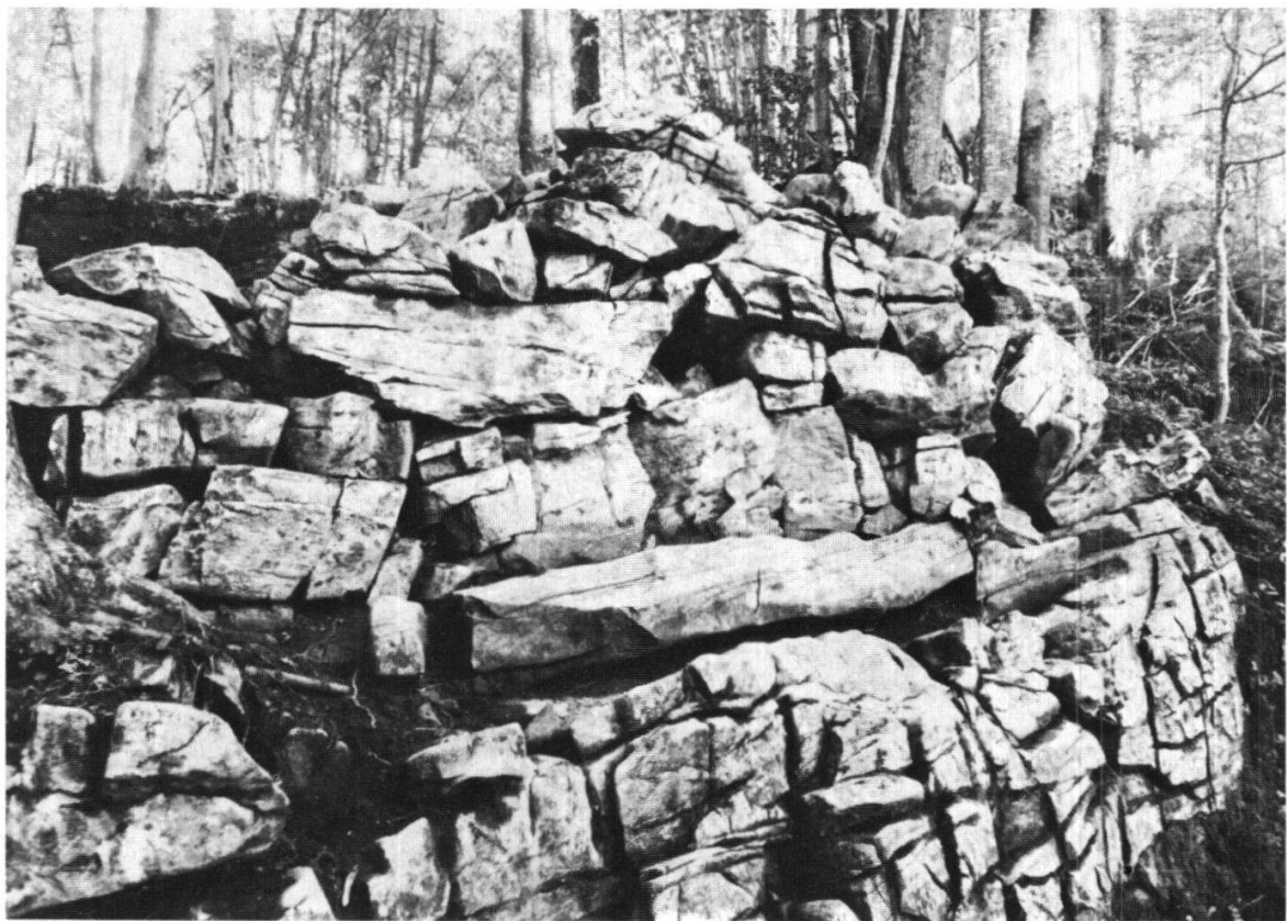
Illgau/Balmis 1987, Gebäude 1. östliche Außenmauer über natürlichem Felsband, Ansicht von Südosten.
