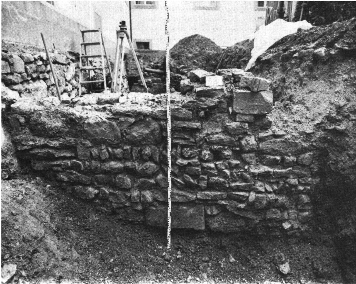
Abbildung 17: Die selbe Mauer 38 Nord auf der Gegenseite (Fundamentbereich, in Grube gegossen).
