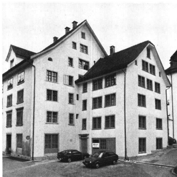
Einsiedeln, Haus Adler und Halbmond. Restaurierter Teil des Doppelhauses mit in der Form originellen Barockfenstern.
