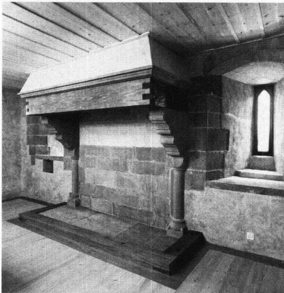
Pfäffikon, Statthalterei Schloßsturm. Romanisches Cheminée im zweiten Ober- geschoß.
