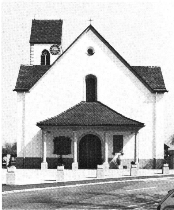
Wangen, Pfarrkirche St. Kolumban. Äußeres nach der Restaurierung mit neuem Vorzeichen.
