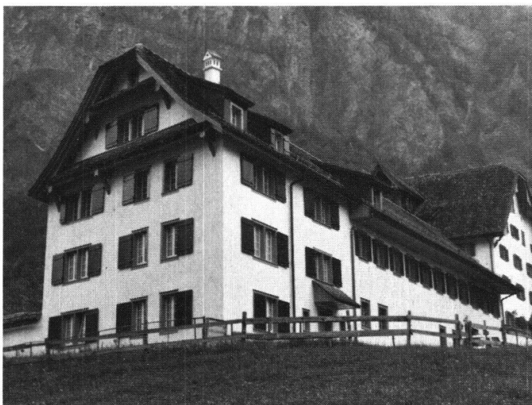
Muotathal, Frauenkloster St. Joseph. Das Kaplanenhaus gehört zum ältesten Baubestand der Klosteranlage.
