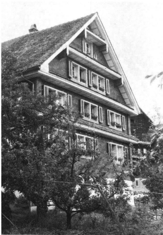
Steinerberg, Bauernhaus Diezigen. Westansicht nach der Restaurierung.
