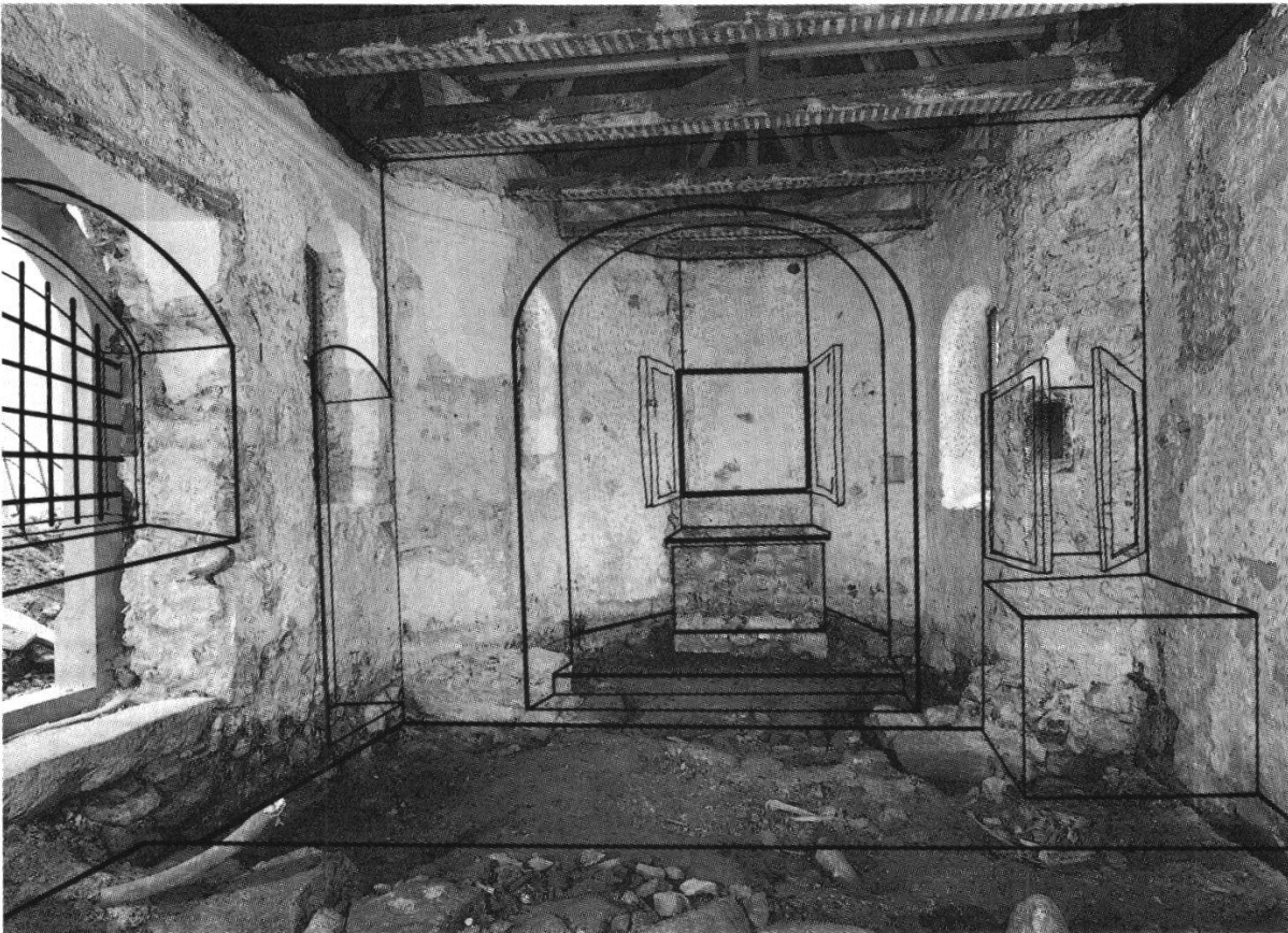
Abbildung 9 Ostteil des Schiffes und Chor des Beinhauses zur Zeit der archäologischen Untersuchungen. Als Rekonstruktion eingezeichnet sind die ursprünglichen Bauteile sowie die Altäre (Foto Fibbi-Aeppli).
