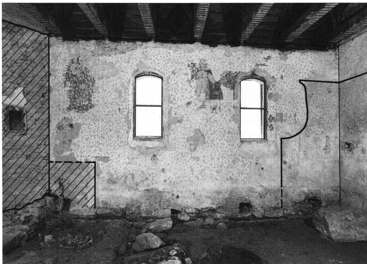
Abbildung 6 Südwand des Schiffes zur Zeit der archäologischen Untersuchungen. Links im Bild sind (schraffiert) der vermauerte Ausriß der südlichen Chorschulterwand und daran angrenzend die aufgrund von Verschmutzungen faßbare Form des ehemaligen Nebenaltars zu erkennen. Die Mauertlöcher im untern Teil der Wand sind 1828 zur Belüftung des Hohlraumes unter dem Fußboden angelegt worden (Foto Fibbi-Aeppli).
