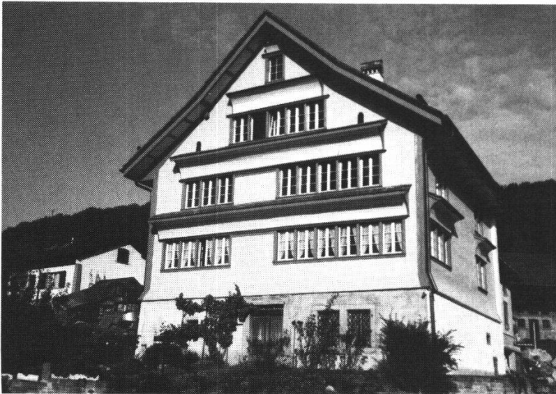
Tuggen, Wohnhaus Ziltener. Bei zahlreichen Märgler Häusern ist der ostschweizerische Einfluß deutlich spürbar. Merkmale sind u.a. die gerundeten Untersichten der Klebdächer und das ins Erdgeschoß verlegte, reich ausgebildete Portal.
