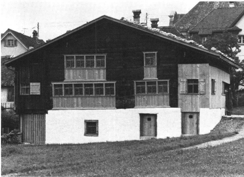
Schwyz, Haus Bethlehem. Die Hauptfront des Bethlehem zeigt die Prinzipien, die für die Restaurierungsmaßnahmen erarbeitet wurden. Das Haus behielt das Aussehen, das es um 1700 erhalten hatte. Die vergrößerten Fenster mit der Putzenverglasung und den Ziehläden sowie die beiden seitlichen Lauben, die gegen Ende des 18. Jahrhunderts in Zimmer umfunktioniert wurden, blieben erhalten.
