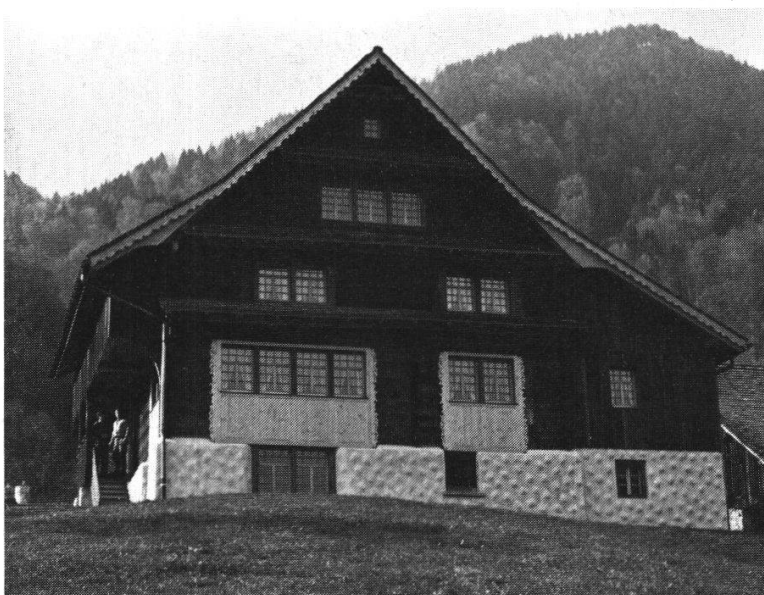
Sattel, Bauernhaus Dietzigen. Zustand nach der Wiederherstellung der Ziehläden. Der gut gemeinte, aber als geschmäckerlich zu bezeichnende Sokkelputz wird korrigiert.
