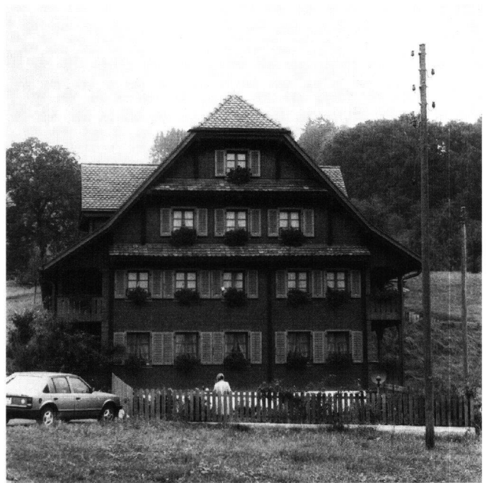
Abb. 26: Küssnacht, Haus Zelgerhöfli, Haltikon. Der Umbau des 19. Jahrhunderts hat das wesentlich ältere Gebäude stark, aber in traditioneller Art verändert. Dieser Zustand wurde bei der Restaurierung beibehalten.
