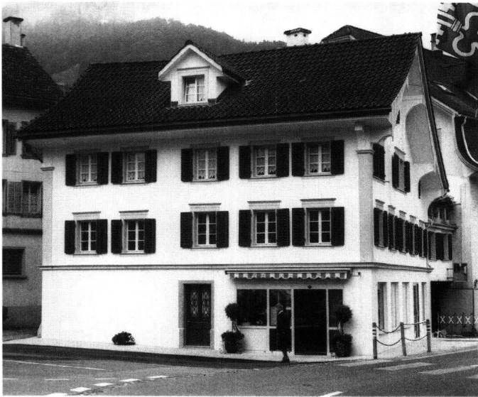
Abb. 14: Steinen, Krone. Die Krone besitzt am Dorfplatz von Steinen einen sehr hohen Stellenwert. Die platz- und strassenseitigen Fassaden wurden um die Mitte des 19. Jahrhunderts im Stil der Zeit verändert.
