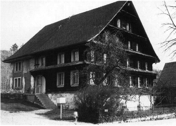
Abb. 27: Freienbach, Haus Breitenstrasse 100. Der strassenseitige Holzbau wurde im 18. Jahrhundert einem spätgotischen Steinhaus vorgebaut.
