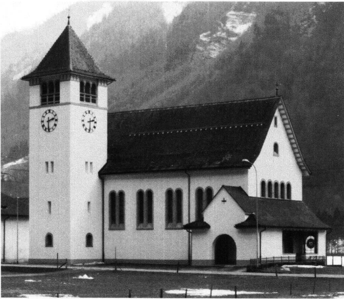
Abb. 6: Muotathal, Kirche Ried. Die Gestaltung des Äusseren verrät den Übergang von Historismus zur Moderne. In die strenge Gesamtgestaltung sind Gestaltungselemente des späten Historismus integriert.
