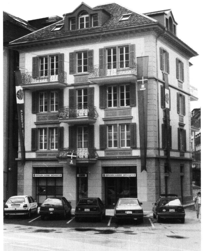
Abb. 3: Ingenbohl, Haus Weber, Bahnhofstrasse 5, Brunnen. Das Haus Weber im Ortskern von Brunnen ist als typisches Geschäftshaus des 19. Jahrhunderts konzipiert. Im leicht überhöhten Erdgeschoss sind Verkaufsgeschäfte integriert. In den Obergeschossen des streng kubischen Gebäudes befinden sich Wohnungen.
