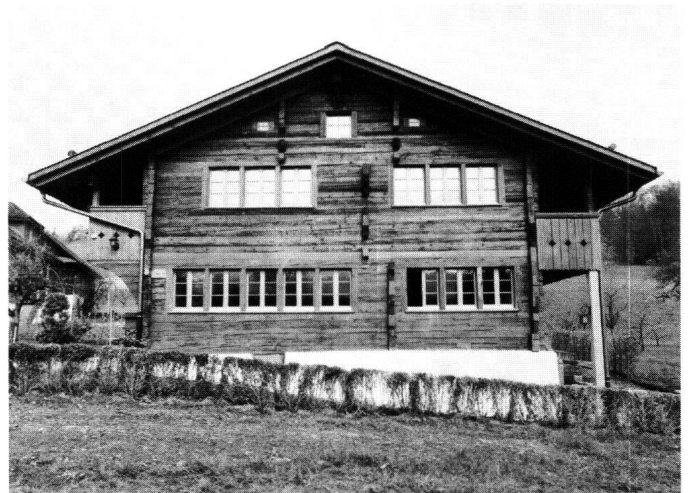
Abb. 22: Küssnacht, Haus Ulrich, Haltikon. Das kleine Holzhaus unmittelbar neben der Kapelle gehört zu den seltenen Vertretern des Tätschdachhauses im Raume Küssnacht. Durch das Öffnen der Reihenfenster konnte der horizontale Charakter des Gebäudes betont werden. Typisch für die Erbauungszeit ist das Fehlen von Klebdächern, die am Bauernhaus erst im 17. Jahrhundert in Mode kommen.
