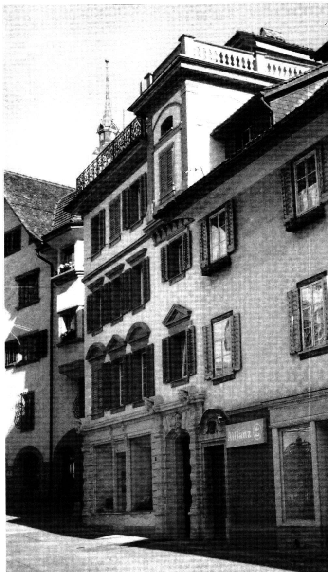
Abb. 11: Schwyz: Haus Dusser, Strehlgasse. Unter der reichen Fassadendekoration des 19. Jahrhunderts verbirgt sich ein Fachwerkbau, der unmittelbar nach dem Dorfbrand von 1642 entstanden sein dürfte.
