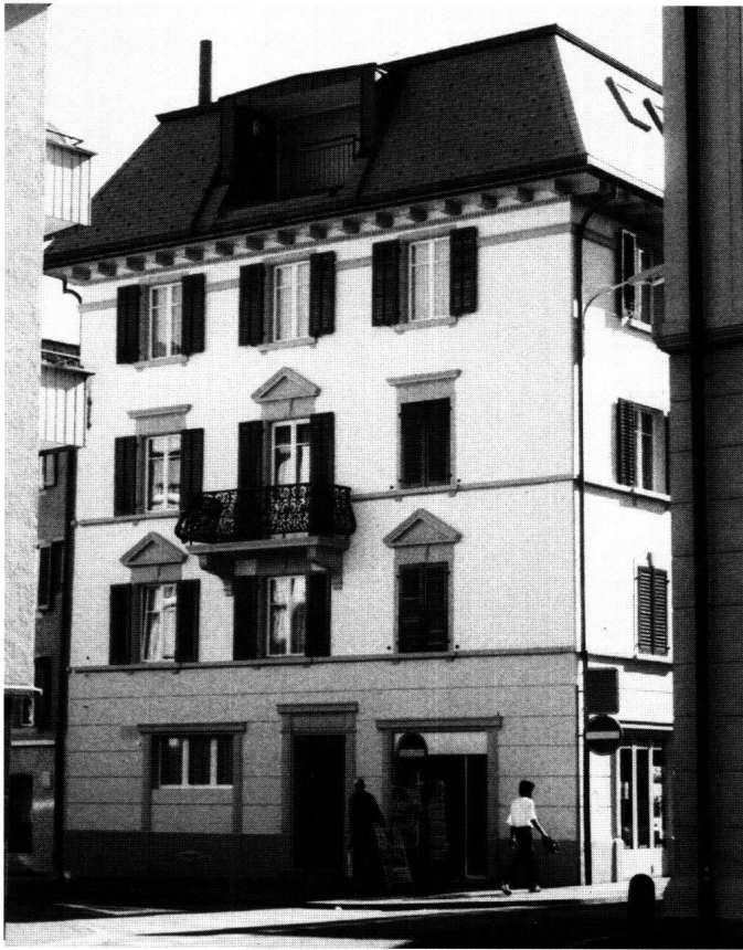
Abb. 21: Lachen: Haus Storchen St. Gallerstrasse 2. Im Kern des Storchen verbirgt sich ein spätgotisches Giebelhaus. Dieses wurde im 19. Jahrhundert durch Aufbauten und Fassadenveränderungen zu einem typischen Geschäftshaus.
