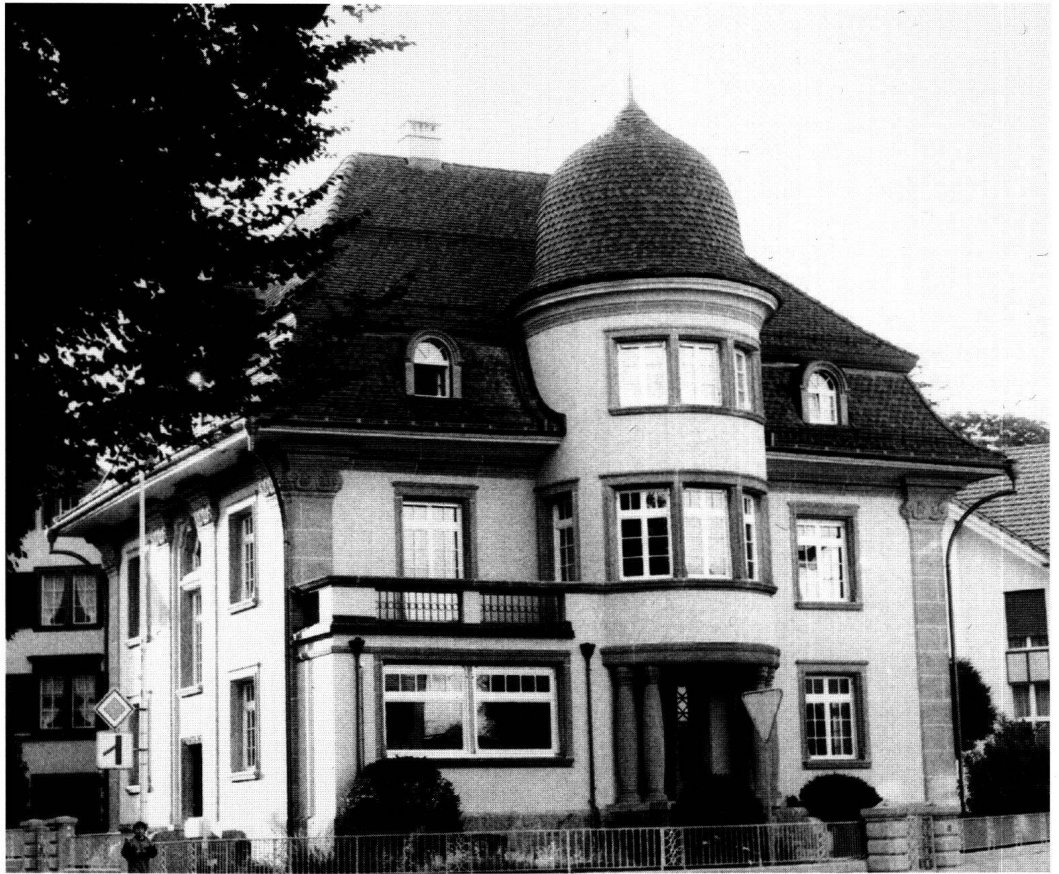
Abb. 20: Lachen: Schwesternhaus, mittlere Bahnhofstrasse 1. Die Hauptfront der ehemaligen Fabrikantenvilla wird durch den runden, vorgebauten Erker mit geschweiften Dachhaube dominiert. Kombiniert sind traditionelle Elemente wie das Mansardendach und moderne Art-Deco-Elemente.
