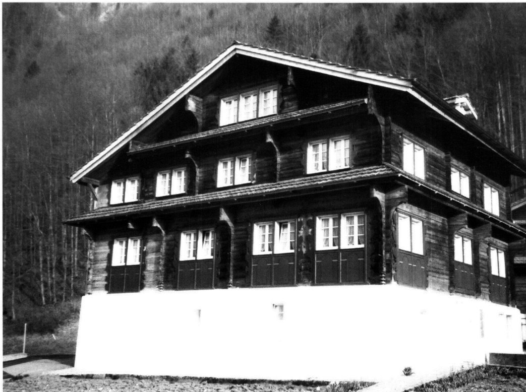
Abb. 14: Muotathal: Pfarrhaus Wil. Das umlaufende Klebdach über dem Hauptgeschoss anstelle der seitlichen Lauben ist für das Erbauungsdatum 1759 durchaus modern. Bunte Ziehläden und Doppelfenster unterscheiden das Holzhaus von einem Bauernhaus der Gegend.
