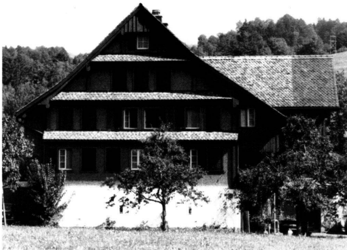
Abb. 16: Sattel: Haus Eumatt, Jansernstrasse 26. Im 19. Jahrhundert wurden die ursprünglichen Reihfenster zu Gunsten von Einzelfenstern mit Jalousieläden aufgegeben.
