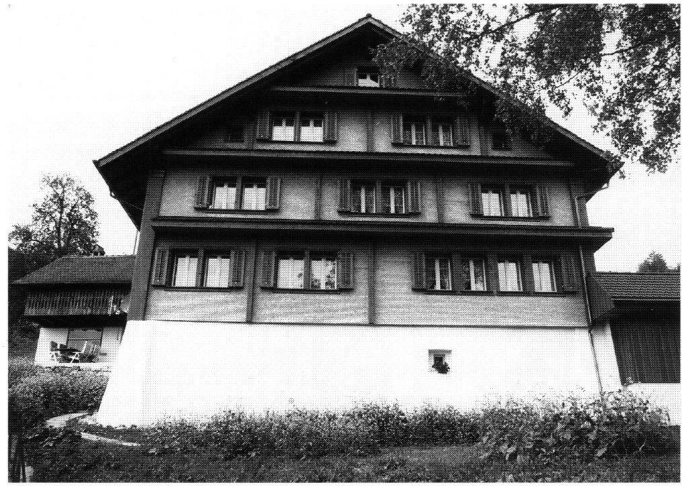
Abb. 3: Schwyz, Engiberg, Haus Kündig. Im Kern des grossen Bauernhauses versteckt sich ein älterer Bau aus dem 18. Jahrhundert. Dieser ist aussen an den Reihenfenstern im rechten (östlichen) Hausteil zu erkennen. Deutlich sind die Eckverstärkungen im Mauersockel zu sehen, die im Rahmen der Hauserweiterung im 19. Jahrhundert vorgemauert worden sind.
