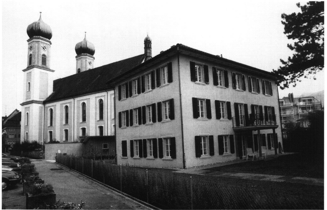
Abb. 10: Lachen, Pfarrhaus. Das seit 1935 als Pfarrhaus benutzte Gebäude ist ein streng gegliederter klassizistischer Baukörper. Die Fassadengestaltung wurde anhand von ähnlichen Objekten rekonstruiert, da am Gebäude selber kein Befund mehr vorhanden war.
