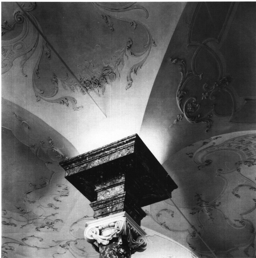
Abb. 22: Einsiedeln, Kloster, Bibliothek. Mittelsäule aus Schliffmarmor. Die Stuckaturen sind ungefasst, die Hintergründe setzen sich in zwei verschiedenen Rosatönen von den hell gekalkten Flächen ab. Die Zugstangen mussten im 19. Jahrhundert eingesetzt werden.
