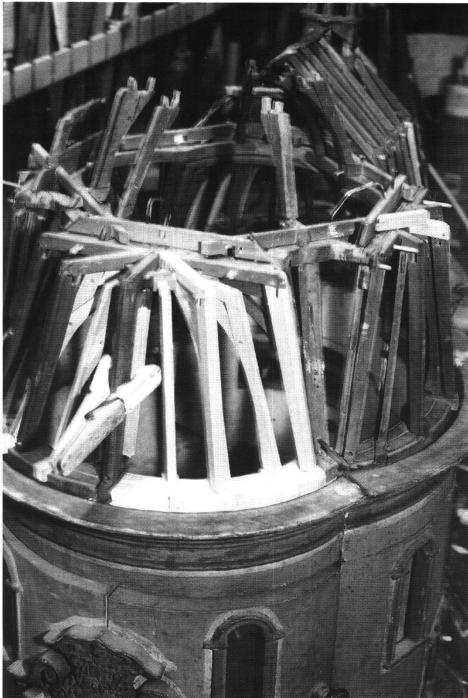
Abb. 3: Der Dachstuhl während des Wiederaufbaus. Die ergänzten Teile sind aus naturfarbig belassenem Lindenzholz geschnitzt und mit Holzzäpfchen befestigt.
