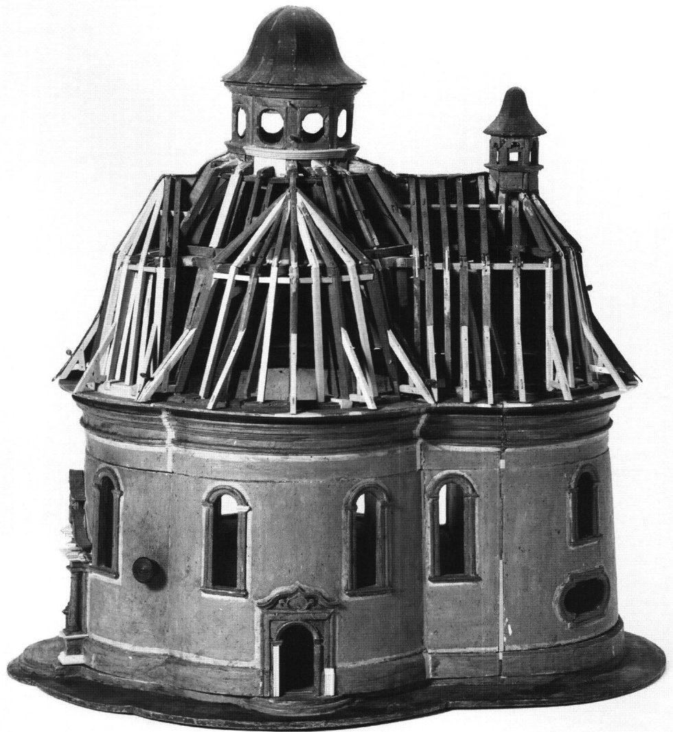
Abb. 5: Die Seitenansicht des Modells mit der offenen Dachfläche. Architektonisch ist diese Fassade gleich ausgebildet wie die gegenüberliegende Modellseite. Hingegen wird hier der Blick in die Konstruktion des komplizierten Dachstuhls freigegeben. Die Konstruktion des Dachstuhls lässt vermuten, dass eine hohe Kuppel geplant war, die bis an den unteren Laternenrand reicht, so dass das Licht von den Laternenfenstern in den Raum eindringen kann. Gut zu erkennen sind die hell belassenen Holzergänzungen an der Fassade und im Dachstuhl.
