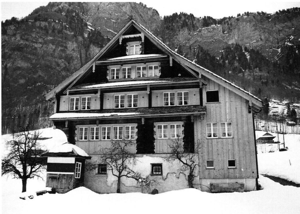
Abb. 8: Muotathal, Haus Hofrog. Die Hauptfront wird von den mit reichen Seitenbärten dekorierten Ziehläden dominiert. Der Anbau mit der senkrechten Brettverschalung gehört in seinem Volumen zum Erstbestand des Hauses.
