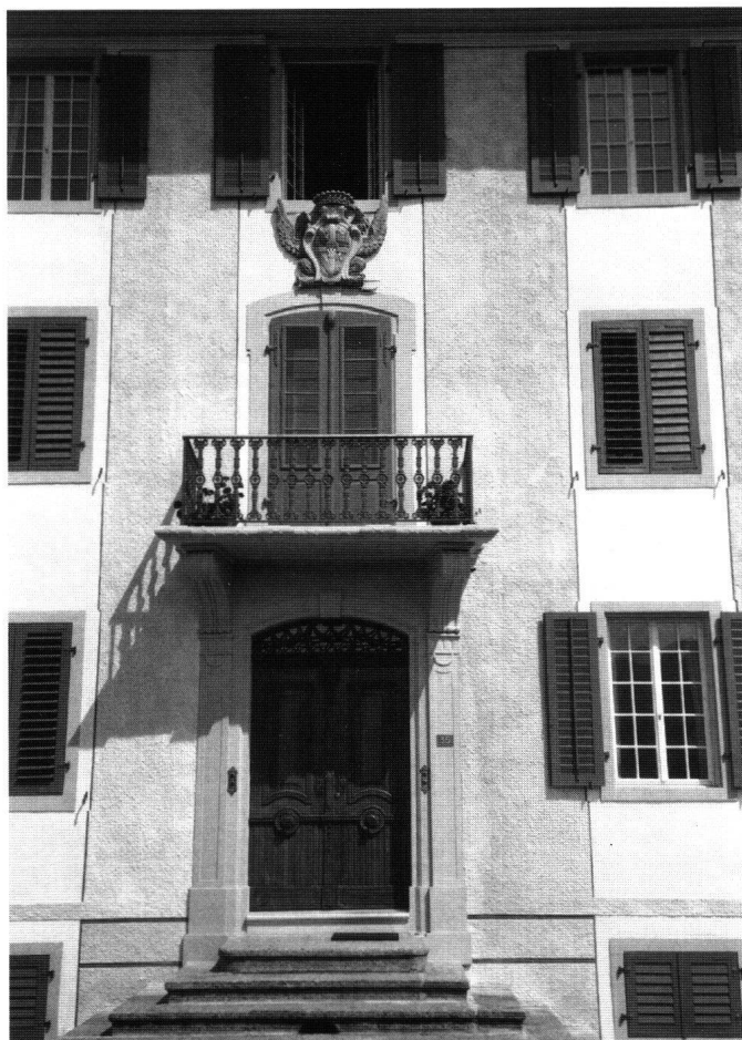
Abb. 3: Schwyz, Haus von Hettlingen. Der westseitige Eingang mit darüberliegendem Balkon und Wappen Hettlingen.
