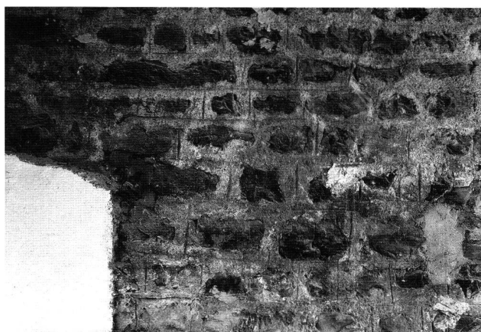
Abb. 15: Steinen, Pfarrkirche St. Jakob. An der ostseitigen Turmfassade hat sich durch den Schutz eines gotischen Sakristeianbaus ein Teil des romanischen Fugenstrichs erhalten.
