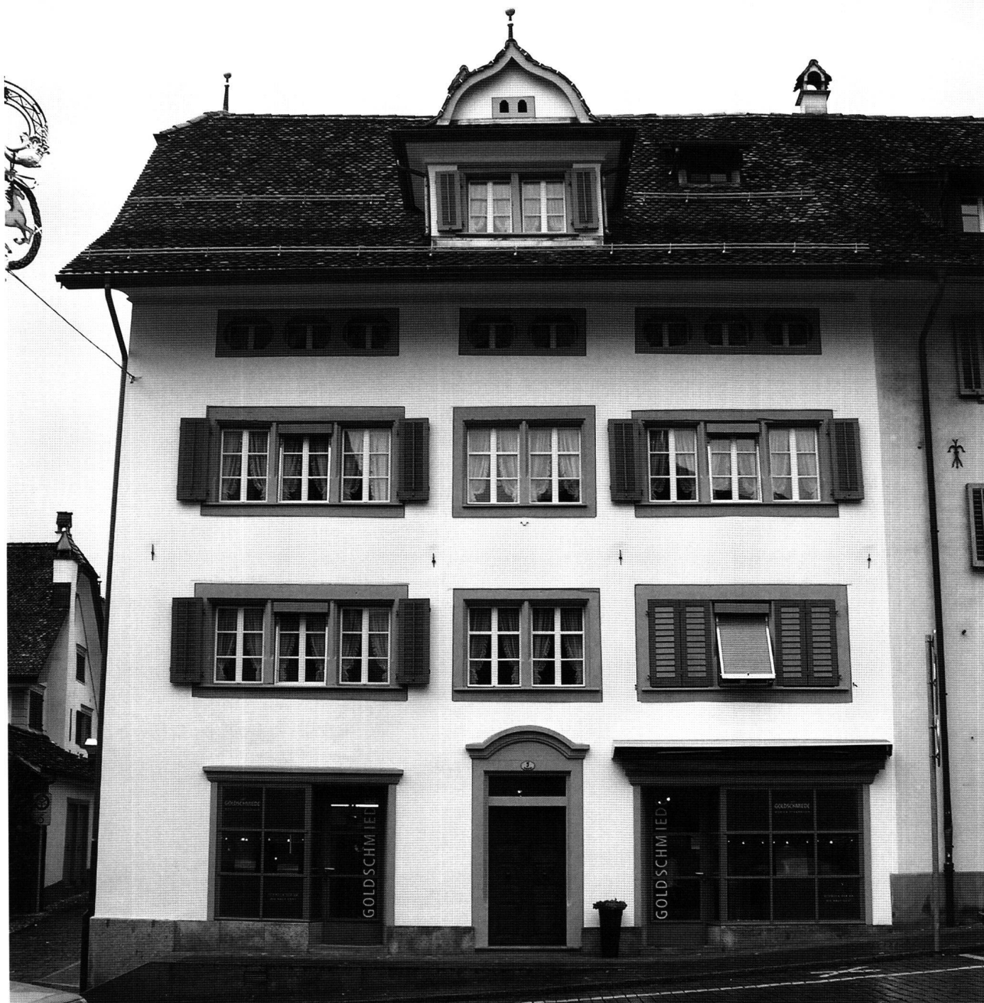
Abb. 9: Schwyz, Haus Castell, Hauptplatz 5. Im 18. Jahrhundert wurde das Haus, das unmittelbar nach dem Dorfbrand von 1642 erbaut worden sein dürfte, barock umgestaltet. Zu dieser Umgestaltung gehören die Ausbildung der Mezzaninfenster, der geschweifte Dachgiebel sowie die vergipste Dachuntersicht. Hingegen blieben dabei die Fenstergerichte des 17. Jahrhunderts in Sandstein und Holz erhalten.
