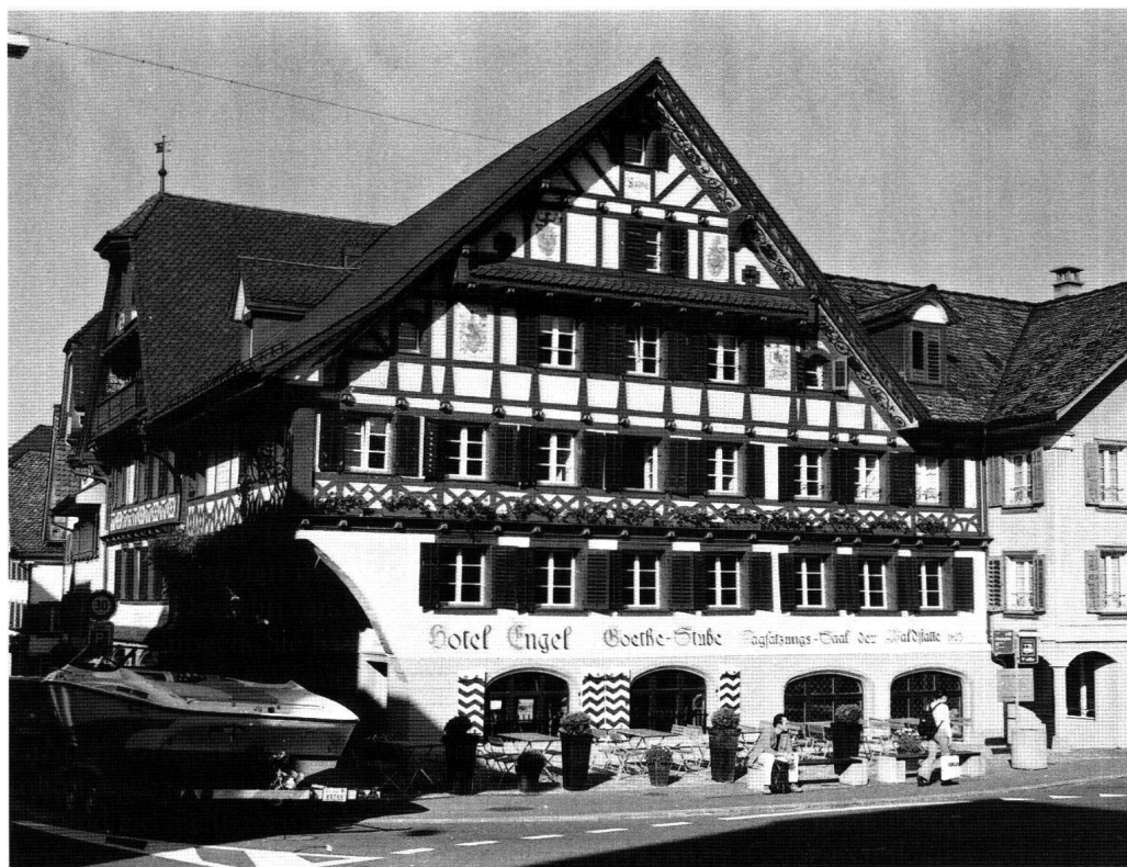
Abb. 19: Küssnacht, Hotel Engel, Hauptplatz 1. Die heutige Fassadengestaltung mit vorgeblendetem Fachwerk entstand im Jahre 1907. Zu diesem Zeitpunkt wurde auch das Innere des Gebäudes stark verändert
