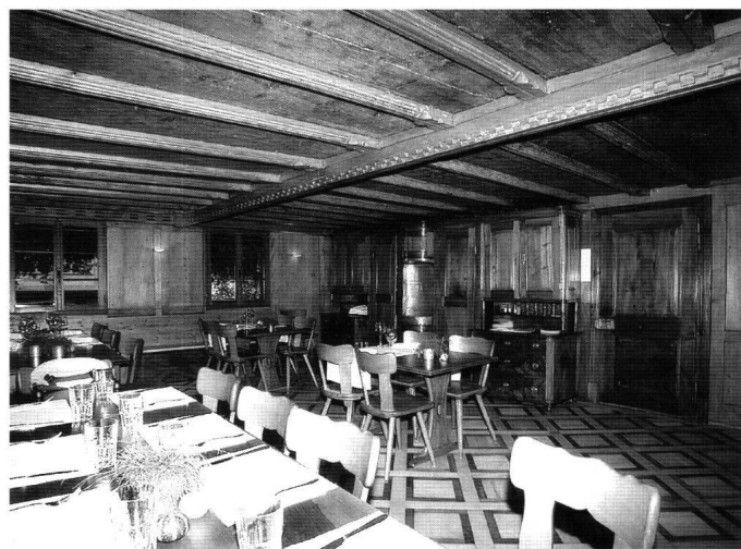
Abb. 21: Küssnacht, Hotel Engel, Hauptplatz 1. In der Goethestube ist in wesentlichen Teilen eine spätgotische Rillendecke erhalten. Im Hintergrund ein Biedermeierbüfett und ein gleichzeitiger Parkettboden.
