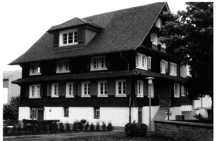
Abb. 10: Arth, Haus St. Georg, Rigiweg 26. Das herrschaftliche Holzhaus bildet zusammen mit der Kapelle St. Georg eine bedeutende Baugruppe.
