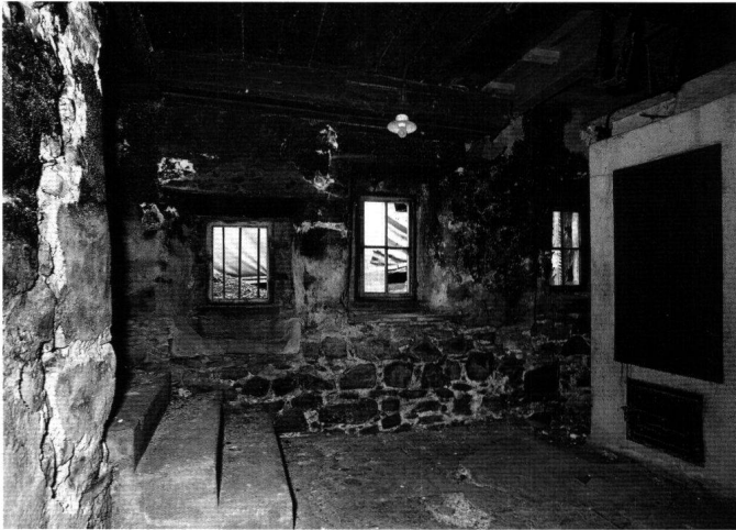
Abb. 30: Erstes Obergeschoss, Küche 1.8, Ansicht gegen Norden.
