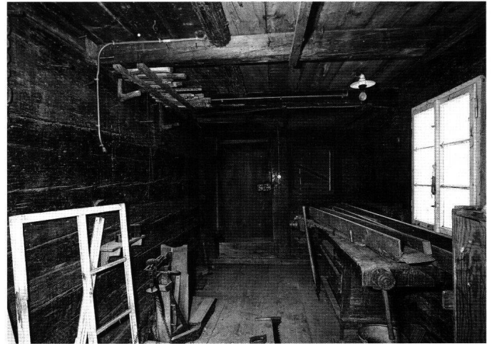
Abb. 36: Erstes Obergeschoss, Kammer 1.4, Ansicht gegen Norden.
