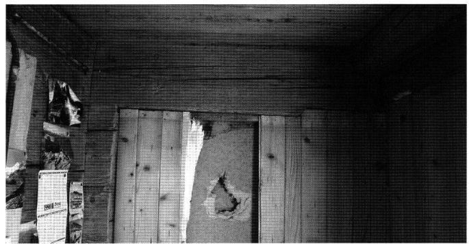
Abb. 29: Erstes Obergeschoss, Südwand von Raum 1.3. Der oberste Wandbalken als Rest einer Stützkonstruktion für die auskragende Kammer des zweiten Obergeschosses.
