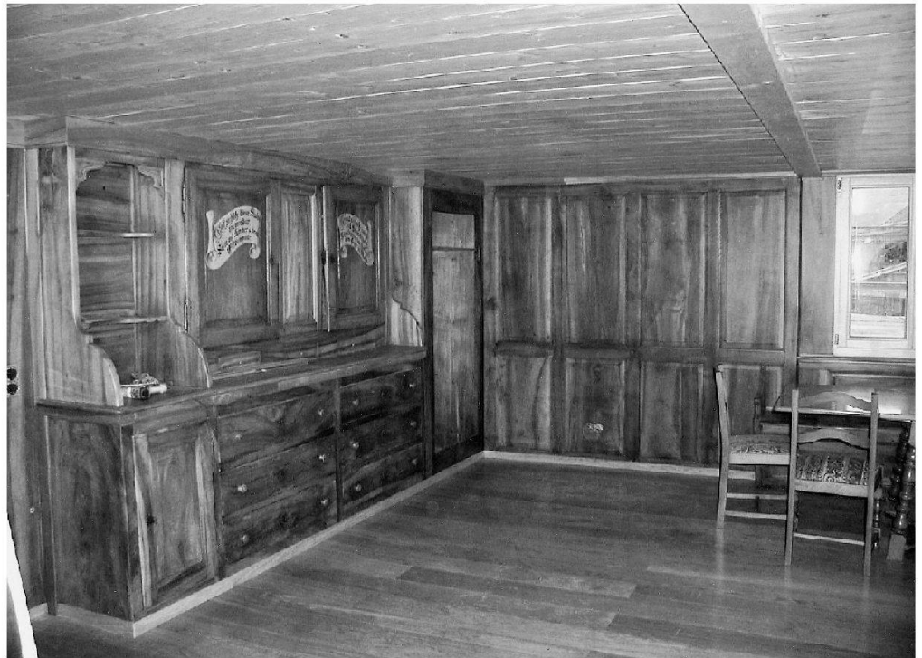
Abb. 4: Schwyz, Hinteres Herrenfeld (Nauerhaus). In der grossen Stube gehören Büffet und Wandtäfel zur Ausstattung des 18. Jahrhunderts. Die Decke wurde in schlichter Form ergänzt.
