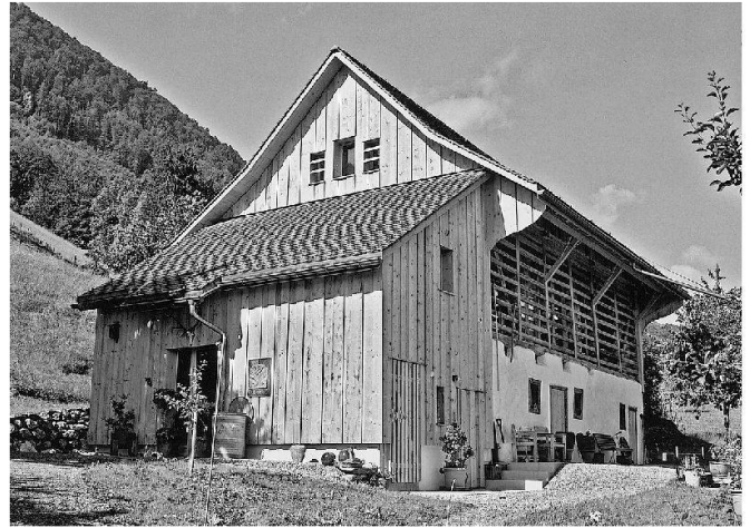
Abb. 11: Schübelbach, Scheune im Nasstal. Die Eingriffe, die für die Umnutzung des Stalls zur Wohnung nötig waren, sind aussen kaum auszumachen.
