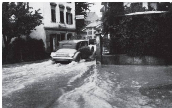
Wenn die Bäche ungenügend verbaut sind, können in Siedlungsgebieten durch Überschwemmungen schwere Schäden entstehen wie 1955 in Lachen.
