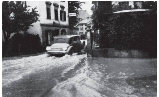
Wenn die Bäche ungenügend verbaut sind, können in Siedlungsgebieten durch Überschwemmungen schwere Schäden entstehen wie 1955 in Lachen.
