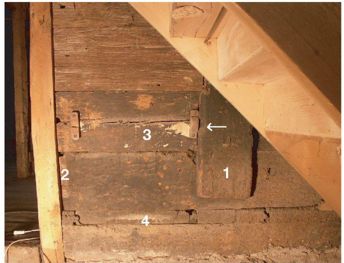
Abb. 16: Ostwand des Ganges (1.1). 1: Mantelstud zur Stube (1.3) mit Fasse und Schild (Pfeil); 2: Negativ des nördlichen Mantelstudes auf dem Schwellbalken; 3: nachträgliche Verfüllung; 4: Boden-Bohlen.
