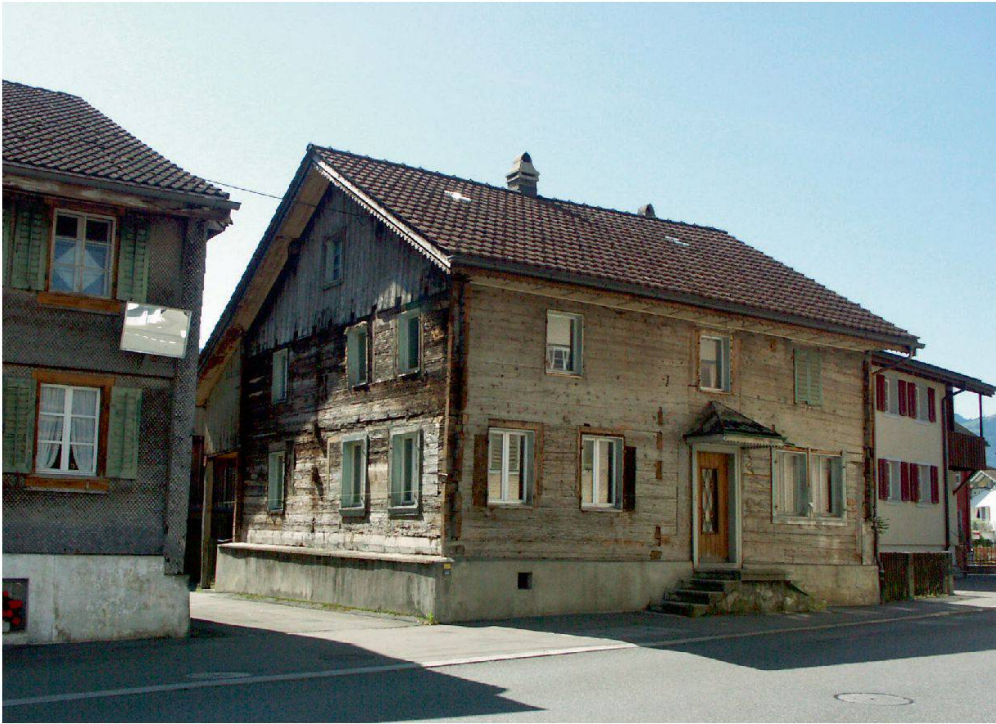
Abb. 2: Das Anwesen nach Entfernen der Eternitschindeln, Ansicht gegen Südwesten (Aufnahme September 2008).
