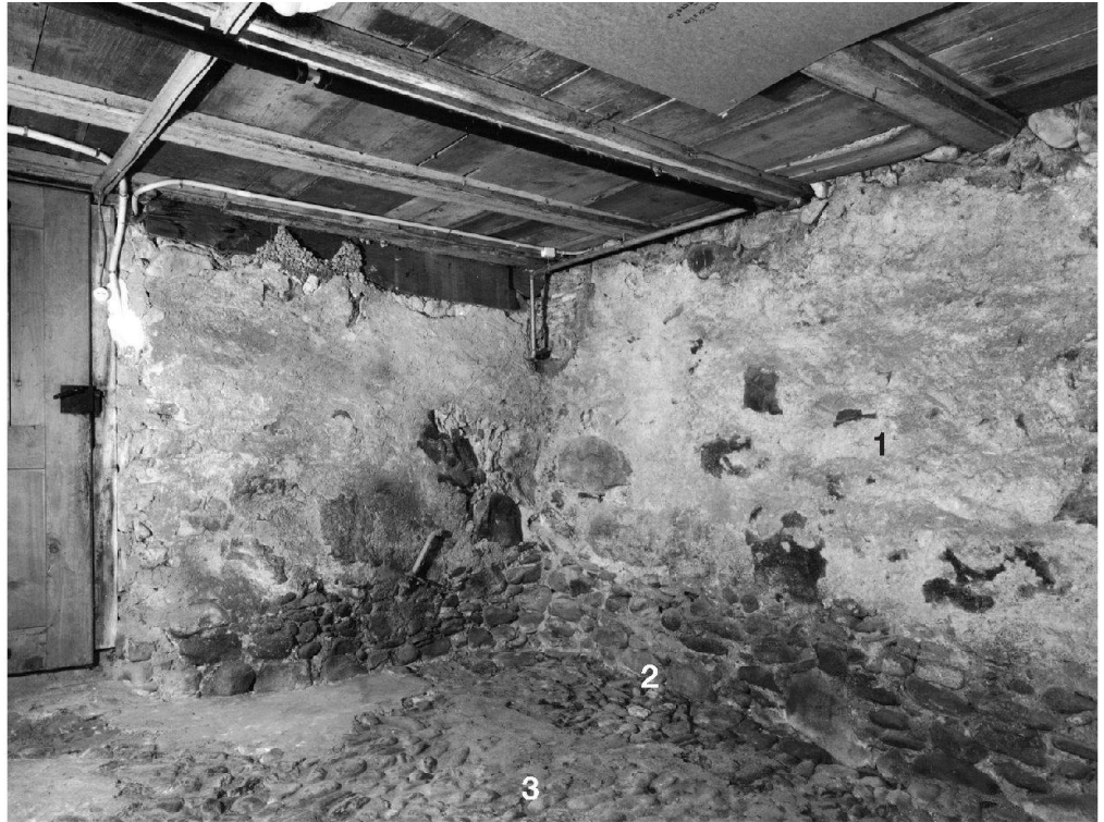
Abb. 28: Südwestecke des Kellerraumes (1.1). 1: verputztes Sockelmauerwerk (erste Hälfte 15. bis erste Hälfte 16. Jahrhundert), 2: kleinformatiges Steinmaterial der Unterfangung (1870); 3: Pflasterung (1870).
