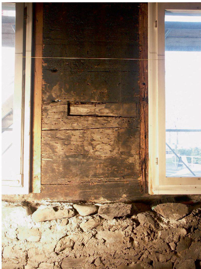
Abb. 6: Westwand der offenen Rauchküche (1.5), originaler Fensterschlitz.
