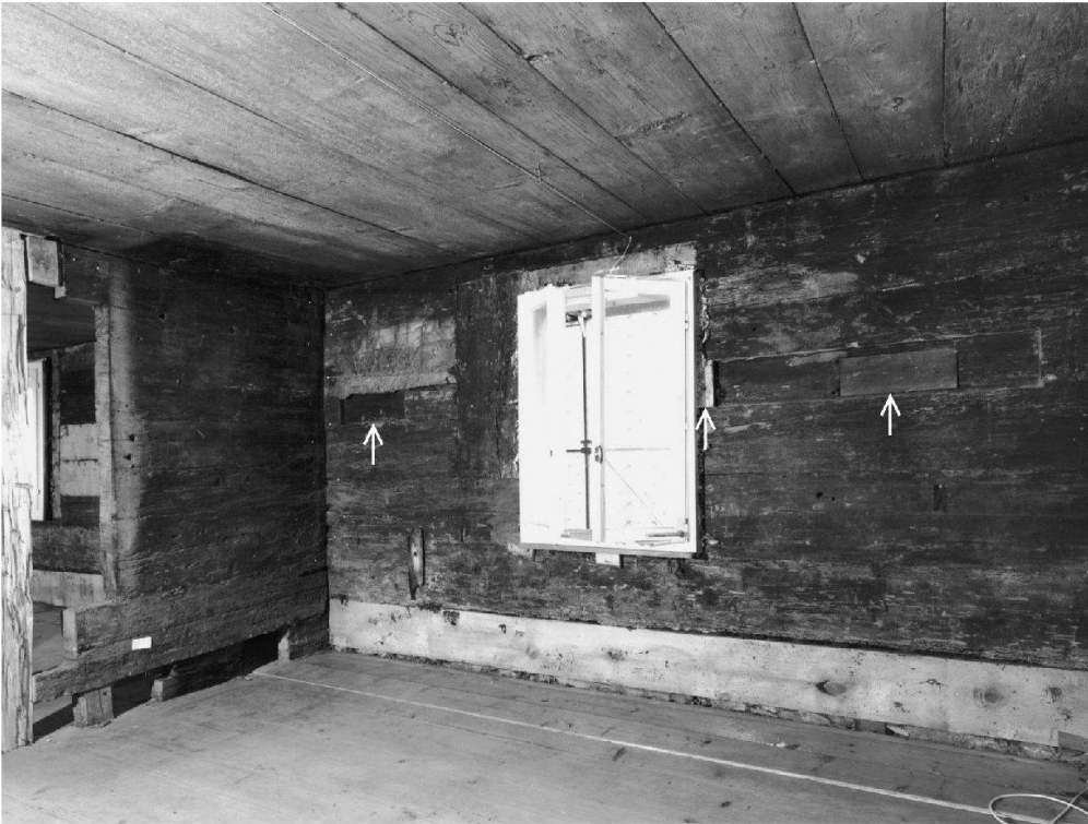
Abb. 18: Ostwand der Stube (1.3), Lukenfenster (Pfeile).
