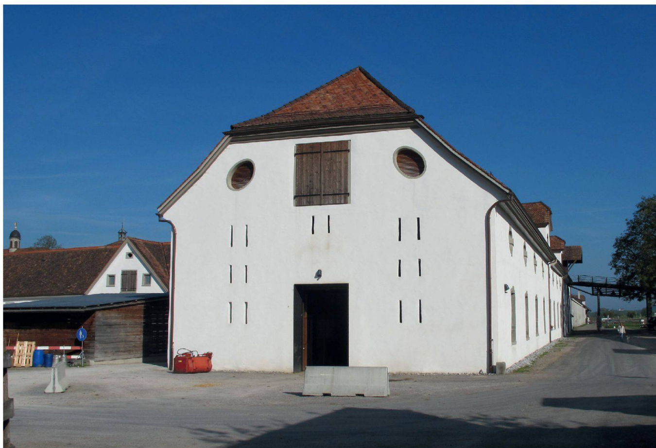
Abb. 18: Einsiedeln, Kloster, Marstall. In der Südfassade ist heute der neue Hauptzugang zum Stall integriert. Wieder geöffnet wurden die kleinen Lüftungsschlitze.
