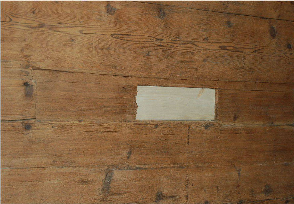
Abb. 11: Steinen, Haus Geisser, Herrengasse 15. In der Nebenstube sind Fensteröffnungen aus der Bauzeit im frühen 14. Jahrhundert erhalten. Gut zu erkennen sind die Rillen, in denen Brettchen zum Verschiessen der Öffnungen eingeschoben werden konnten.
