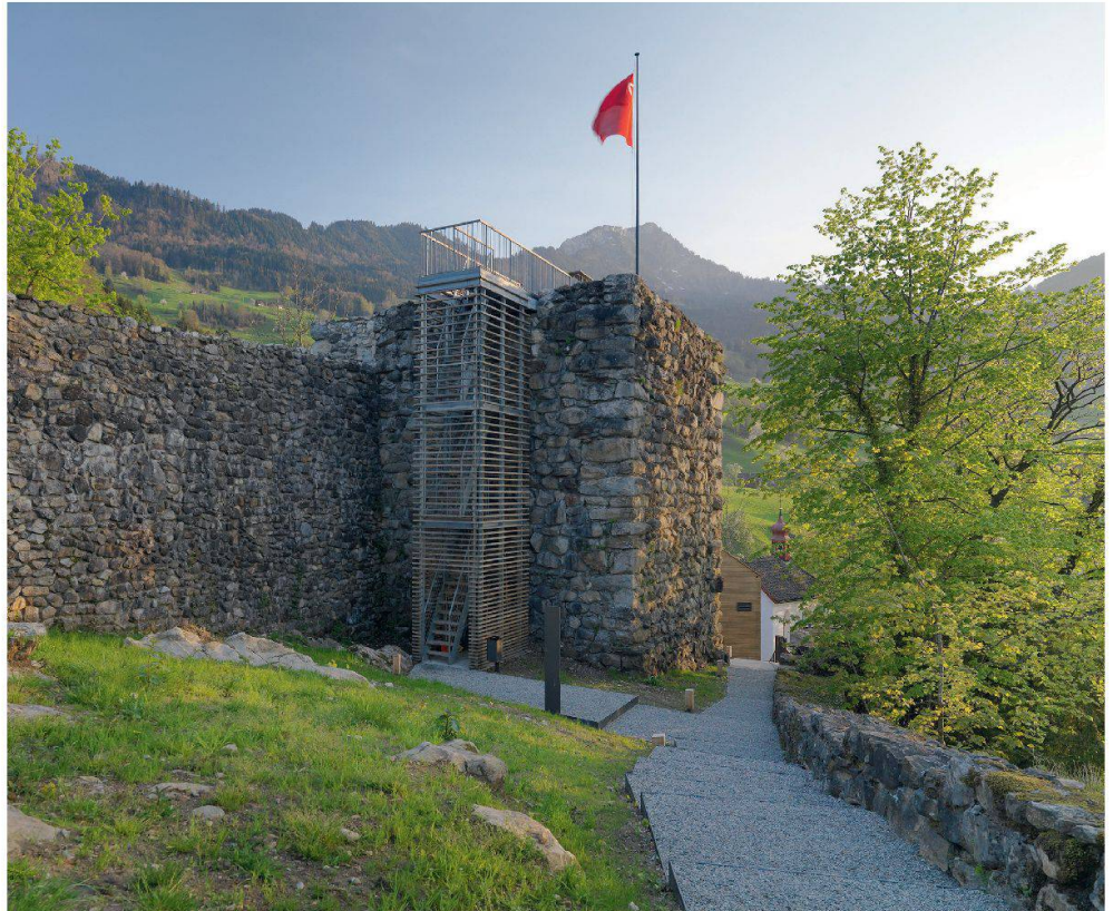
Abb. 17: Lauerz, Insel Schwanau. Der Turm ist neu mit einer Aussentreppe in Anlehnung an den ursprünglichen Aufstieg erschlossen. Der historisch falsche Zugang über die Aussenmauer wurde aufgegeben.
