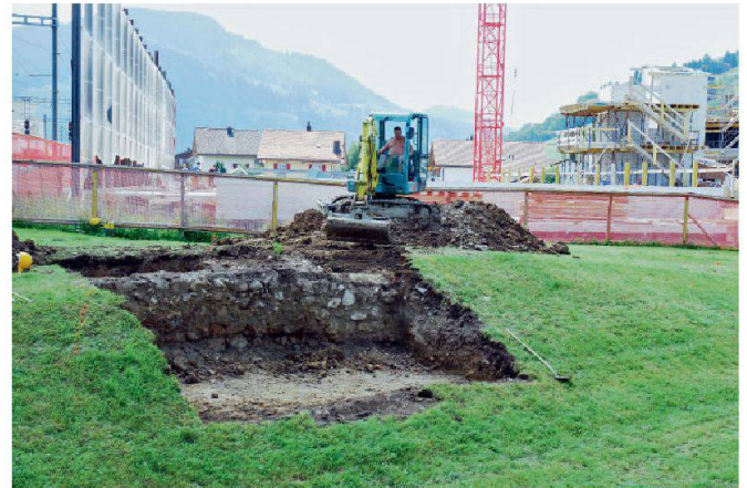
Abb. 1: Letzi Rothenthurm 2009. Freilegen des Fundamentes der Letzimauer mit Hilfe eines Kleinbaggers, von Norden. Im Hintergrund die Baustelle Schulanlage MPS (Mittelpunktschule) Berg.
