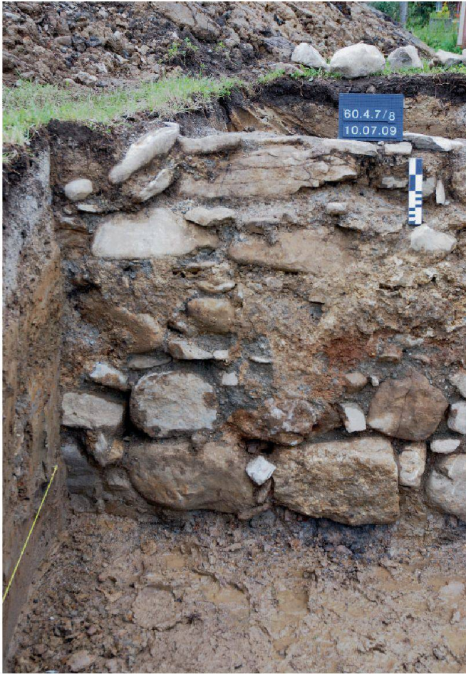
Abb. 12: Letzi Rothenthurm 2009. Feindseitiger Mauerarm mit anhaftenden Resten von Fallmörtel, von Nordnordwesten.
