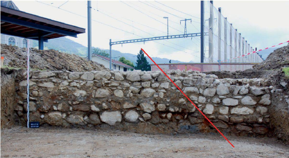
Abb. 17: Feindseitiger Mauermantel des Letzimauerfundaments, von Nordosten. Der schräge Strich markiert die mögliche Lage der Trennlinie zwischen den zwei Baulosen – links mit Fundamentgraben, rechts mit Pfahlfundament.
