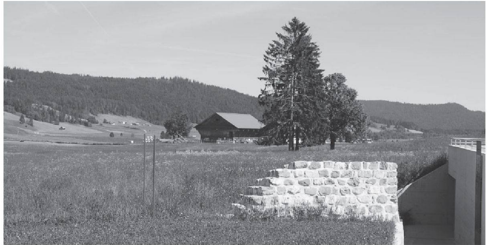
Abb. 16: Letzi Rothenthurm 2009. Kurzer, 2010 rekonstruierter Abschnitt der Letzimauer, von Süden. Rechts im Bild die Rampe, die von der Bahnhofunterführung hinauf zum Schulhaus führt. Links der Mauer zwei der Stangen, die neu den Verlauf der Letzimauer entlang des Schanzgrabens markieren.
