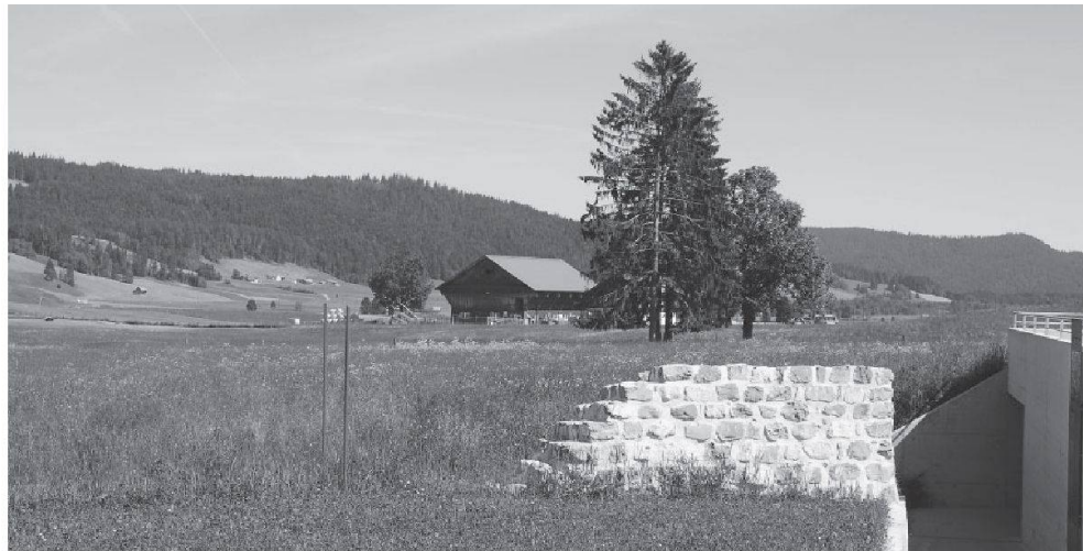
Abb. 16: Letzi Rothenthurm 2009. Kurzer, 2010 rekonstruierter Abschnitt der Letzimauer, von Süden. Rechts im Bild die Rampe, die von der Bahnhofunterführung hinauf zum Schulhaus führt. Links der Mauer zwei der Stangen, die neu den Verlauf der Letzimauer entlang des Schanzgrabens markieren.
