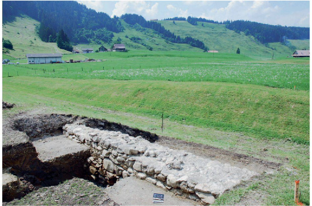
Abb. 4: Letzi Rothenturm 2009. Fundament der Letzimauer nach der Freilegung. Blick auf die Freundseite der Mauer und den Schanzgraben im Hintergrund, von SW.
