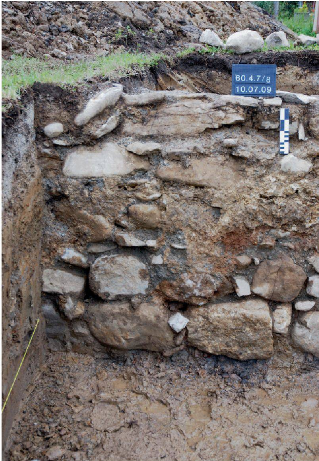
Abb. 12: Letzi Rothenthurm 2009. Feindseitiger Mauermantel mit anhaftenden Resten von Fallmörtel, von Nordnordwesten.
