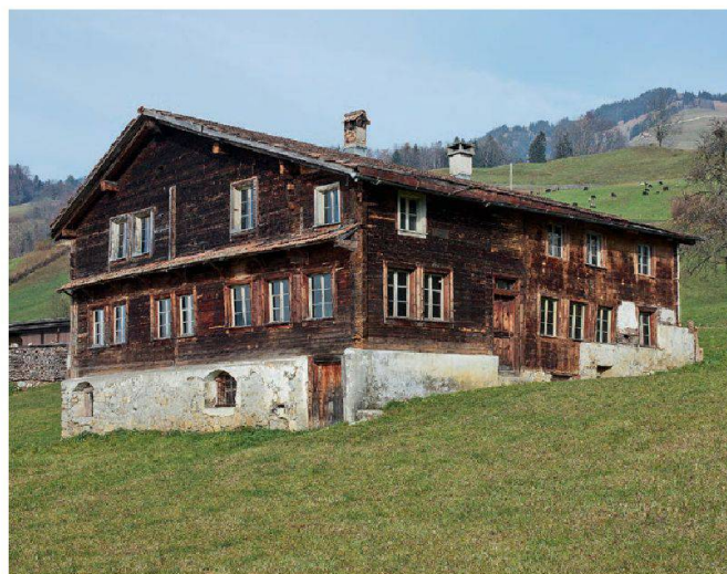
Abb. 2: Die Süd- und Ostfassade des Anwesens.
