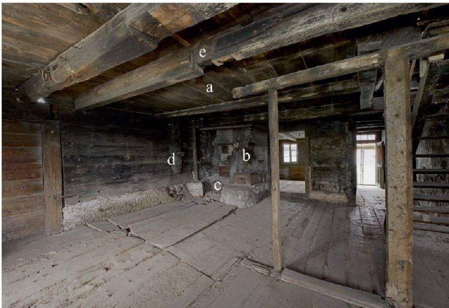
Abb. 16: Küche, Blick gegen Nordosten: im 19. Jahrhundert eingebrachte Deckenbretter (a), Einfeuerungsöffnung des Kachelofens im Nordosttrakt (b) und Wellgrube (c), die im 18. Jahrhundert notwendig gewordene Blockzange (1757/58 dendrodatiert) (d) sowie der Schwellbalken der nordwestlichen Eckkammer des zweiten Wohngeschosses mit Nut für die Aufnahme des Schwellbalkens der Süd- wand (e) im Gründungsbau von 1298.
