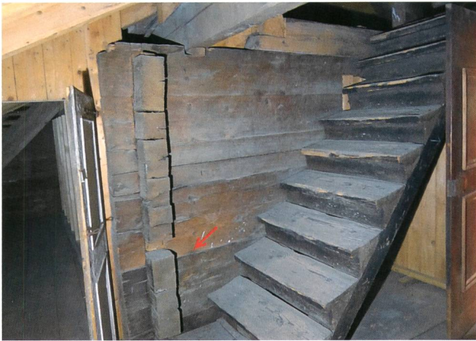
Abb. 6: Erstes Geschoss des Dachraumes, nördliche Kammer, zweiphasige Südwand (Pfeil) und Blocktreppe zum obersten Dachgeschoss.
