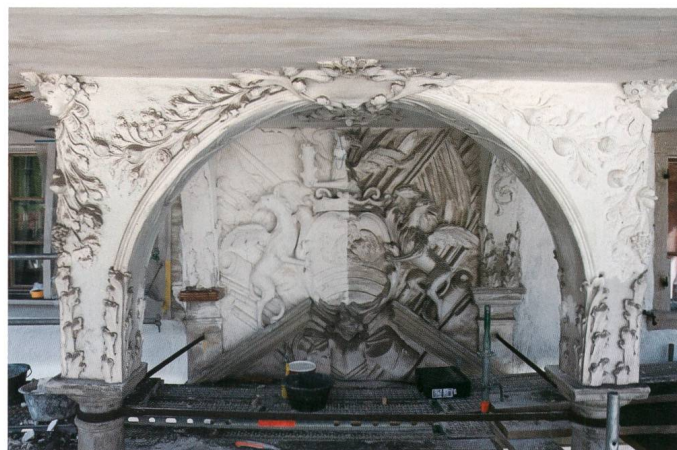
Abb. 27: Stuckaturen über dem Haupteingang des Immenfeldes sind in den Zuständen vor und nach der Restaurierung sichtbar.
