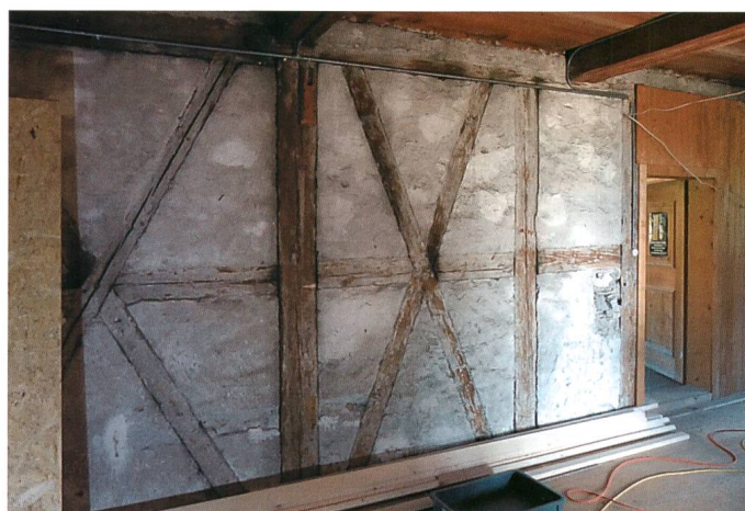
Abb. 14: Erstes Geschoss des Dachraumes, nördliche Kammer, Südwand in Fachwerktechnik (1710d), Blick gegen Norden.
