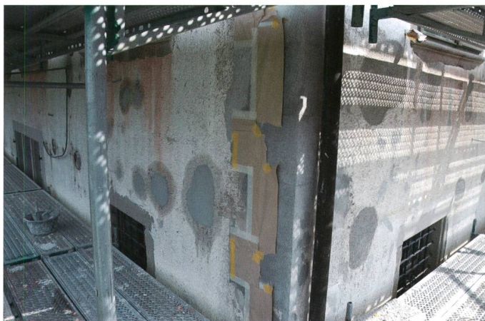
Abb. 26: Mit altem Handwerk konnte die 116-jährige Kalk-Kieselwurf-Fassade restauriert werden. Hausherr und Unternehmer arbeiteten dafür Hand in Hand.
