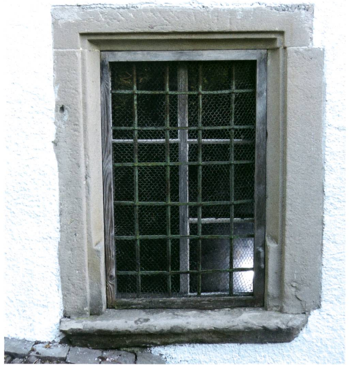
Abb. 10: Westfassade, Sockelgeschoss im Bereich des Hinterhauses, Fenstergewände aus Sandstein, dekoriert mit Kehle und Ablauf.
