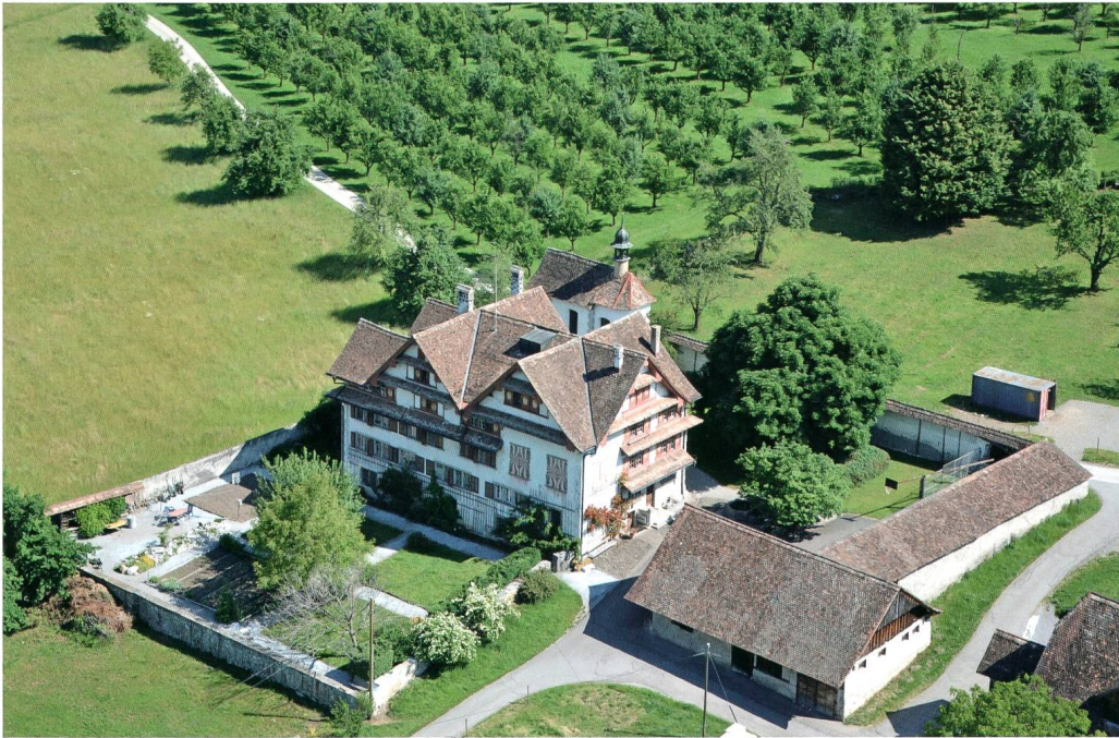
Abb. 2: Flugaufnahme des Gesamtkomplexes, Blick nach Nordosten (vgl. Fussnote 7), vor der Restaurierung 2017–2019.
