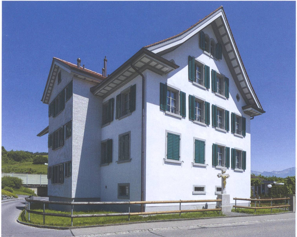
Abb. 10: Wangen, Pfarrhaus: Aussenansicht von Südwesten.
