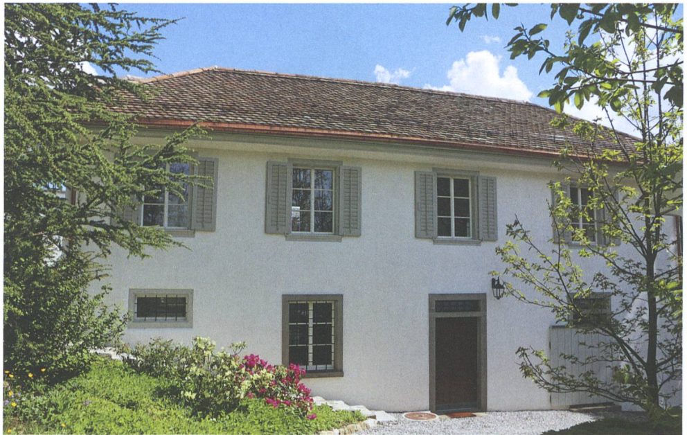
Abb. 3: Schwyz, Palais Kyd, Kappel- matt, Ökonomiegebäude: Aussenauf- nahme von Nordwesten.
