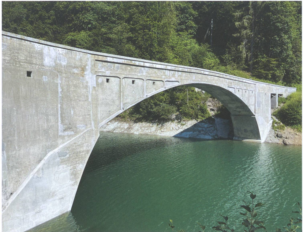
Abb. 8: Innerthal, Schräbächbrücke: Ansicht der restaurierten Brücke von Südosten.
