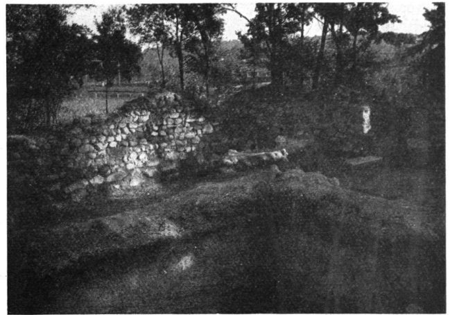
Teil der ausgegrabenen Burgruine Schönwerd
