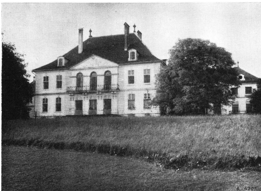
Schloß Hindelbank, Nordfassade
