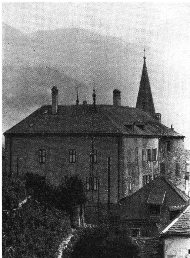
Monthey VS. Schloß, Südfassade vor der Restaurierung
