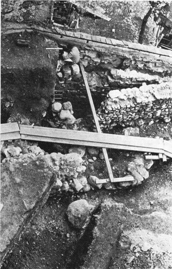
Zug Burg. Blick vom Bergfried gegen Südosten, Grabungsfeld 4. Von vorne nach hinten erkennen wir: Fundamente der frühesten Palasmauer; Erste Ringmauer; erweiterte Ringmauer; Verstärkung der erweiterten Ringmauer.
