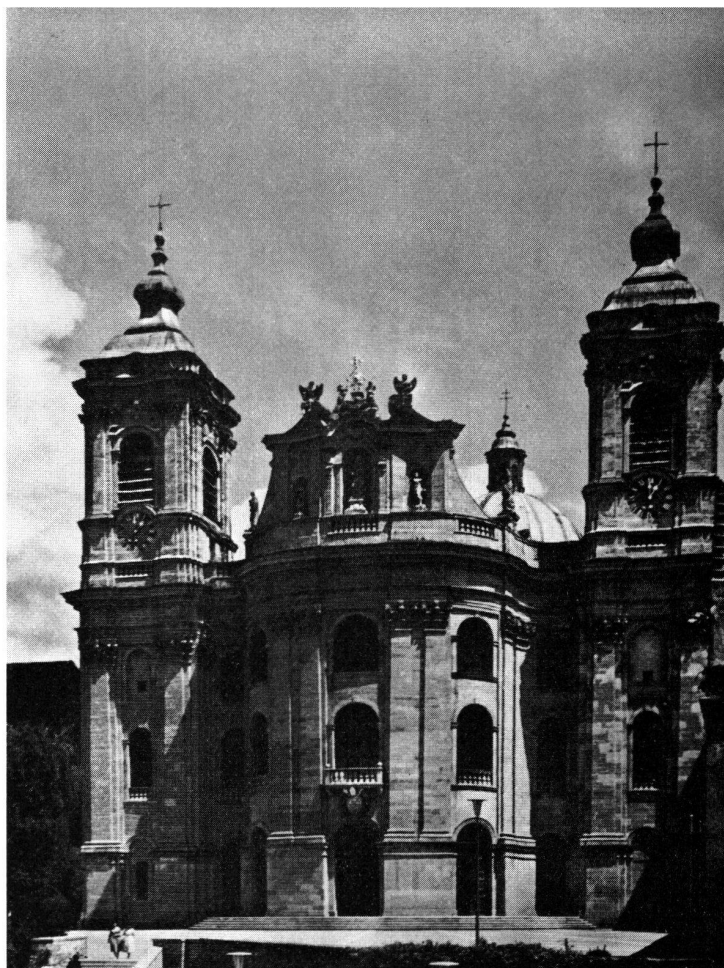
Weingarten, Württemberg Stiftskirche der Benediktinerabtei. Größte Barockkirche nördlich der Alpen. Grablege der Welfen. Erbaut in den Jahren 1715 bis 1724 nach Plänen des Einsiedler Konventualen Br. Caspar Moosbrugger. Gegründet wurde das Stift 1053 durch Herzog Welf III. (Wird vom Burgenverein am 7. Mai besucht.)
