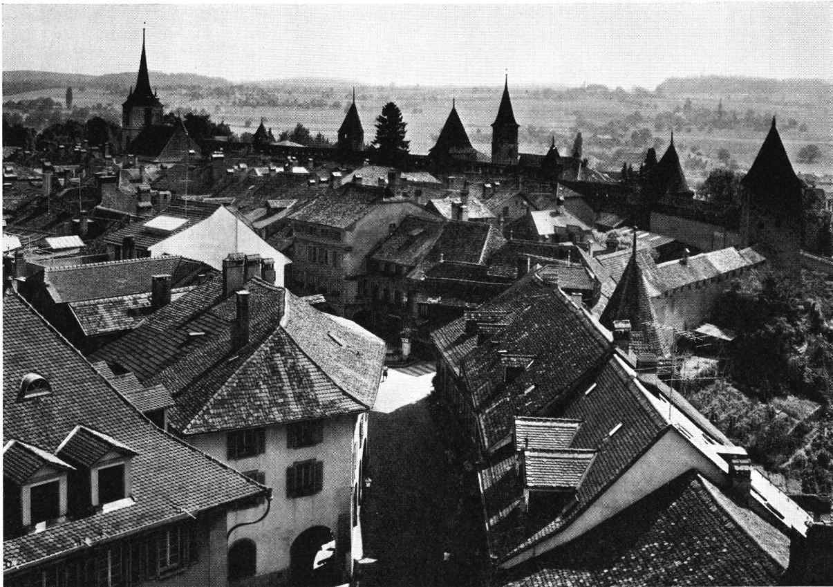
Murten FR ein «Schweizerisches Nördlingen» Blick von Süden auf einen Teil der Stadtmauer mit ihren gedeckten Wehrgängen und Türmen. Am linken Bildrand die reformierte Kirche von 1710–1713. Murten's Befestigungsring zum Schutze der Stadt gegen die Landseite entstand größtenteils zwischen 1238 und 1378 und wurde von 1469 bis nach 1500 massiv verstärkt. Er gilt, neben derjenigen Freiburgs, als die besterhaltene Wehranlage unseres Landes.
