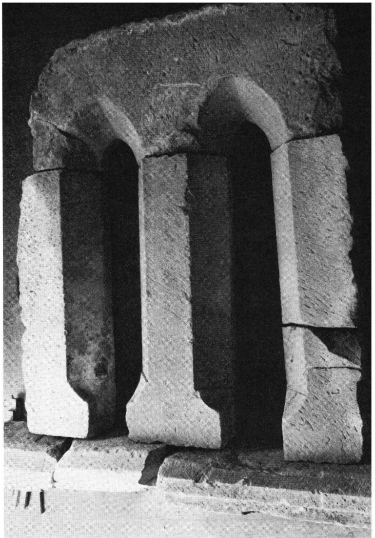
Ruine Scheidegg. Eines der geborgenen Fenstergewände. Scheitelhöhe im Licht 1,15 m.
