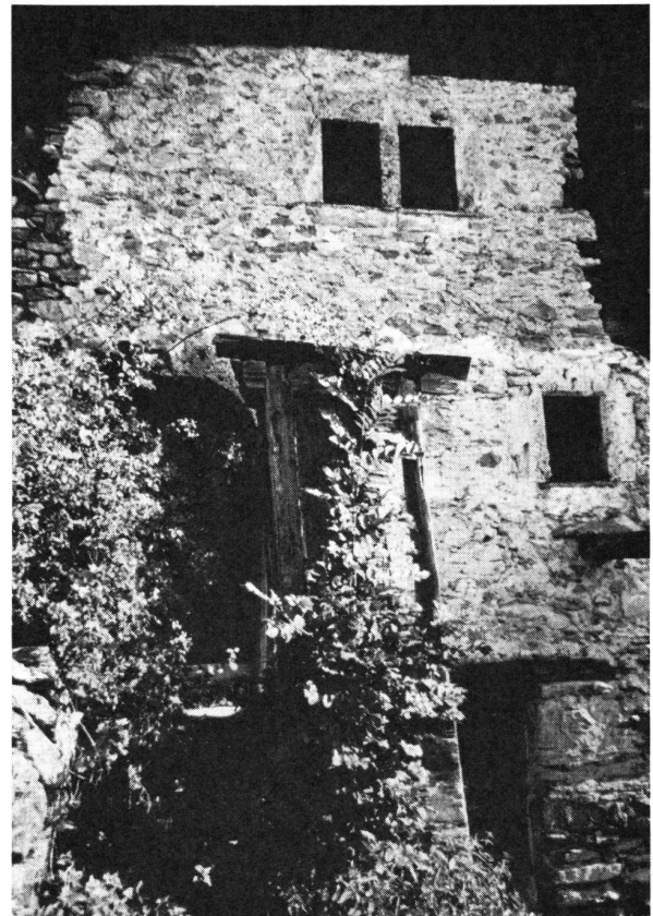
2. Der erhöhte, ursprünglich einzige Hauseingang mit dem romanischen Rundbogen.
