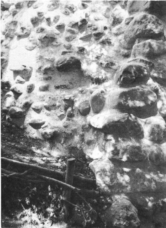
Steinerburg. Mauerhaupt und Füllung nach der Restaurierung.
