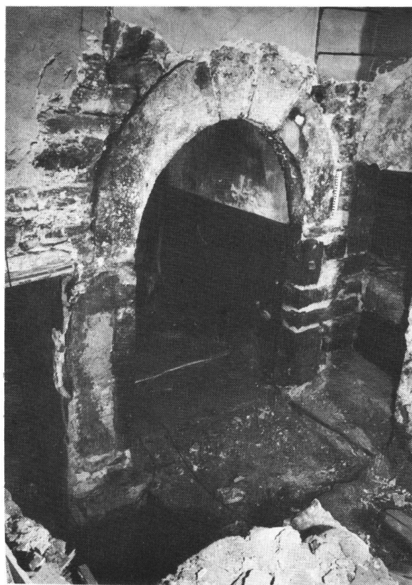
Salzhof in Brig VS. Hocheingang des Wohnturms unmittelbar nach der Entdeckung 1968.
