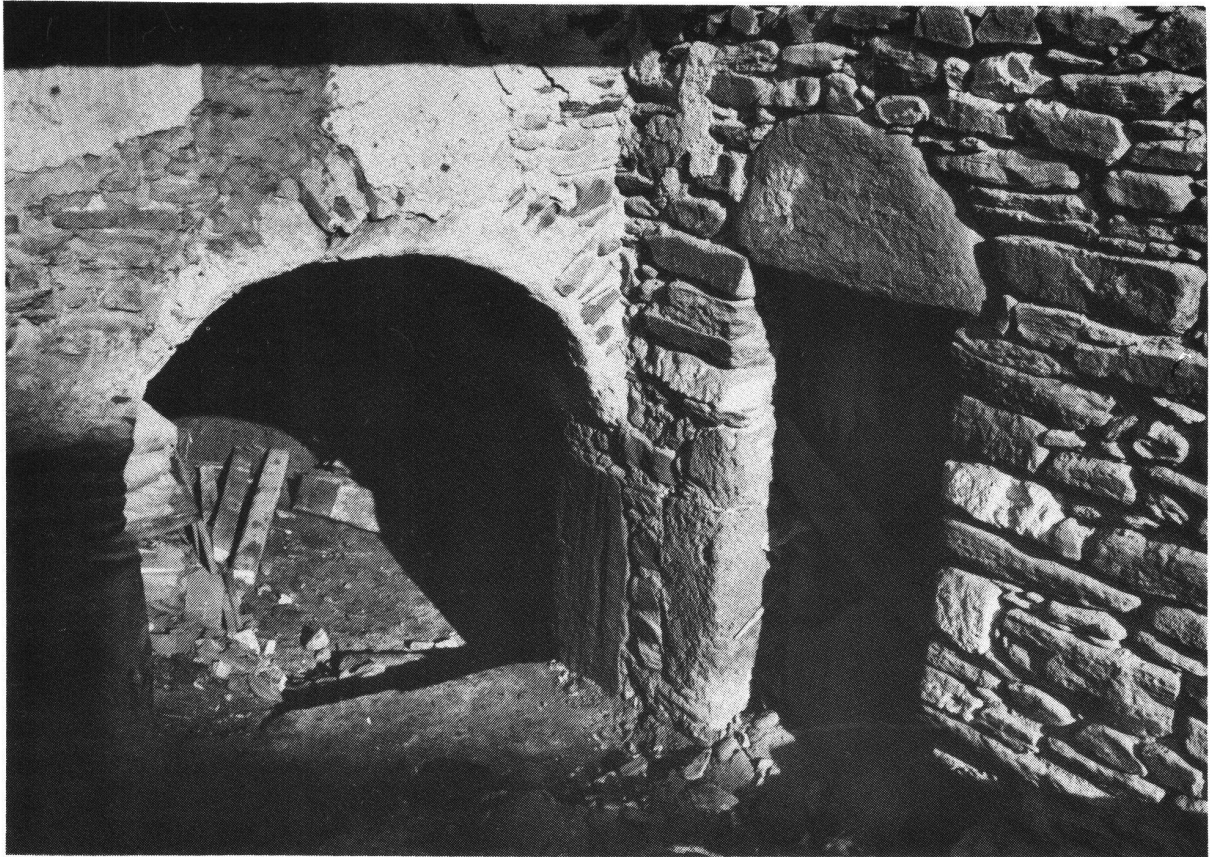
Salzhof in Brig VS. Mauerzusammenschluss M 1c und M 2. Links Kellertüre, rechts Türe in Bau C. Ansicht von SW.
