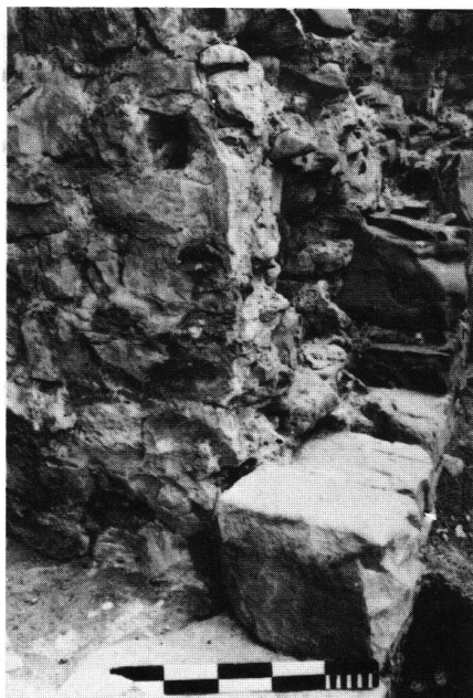
Seedorf, Eingang in den Burgturm mit Gewändstein und Kanal für den Sperr-Riegel
