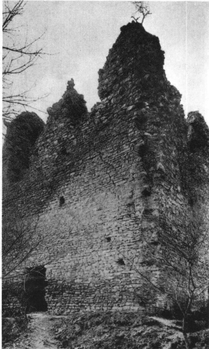
Mittlerer Wartenberg. Zustand um 1920. Das originale Mauerwerk ist heute durch zu weit getriebene Restaurierungsmassnahmen verflastert
