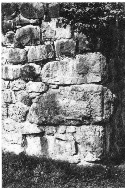
Rudenz OW, Detail, Eckverband mit Kantenschlag
