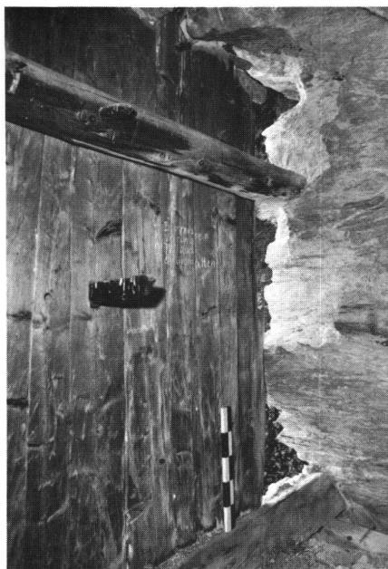
Abb.9 Hérémente VS, grotte aux fées. Verputzter hölzerner Bau, Innenansicht der talseitigen Wand. Am hinteren Felsanschluss waren zwei Licht- und Beobachtungsöffnungen ausgespart. Auf halber Höhe eine Holzkonsole unbekannter Zweckbestimmung.
