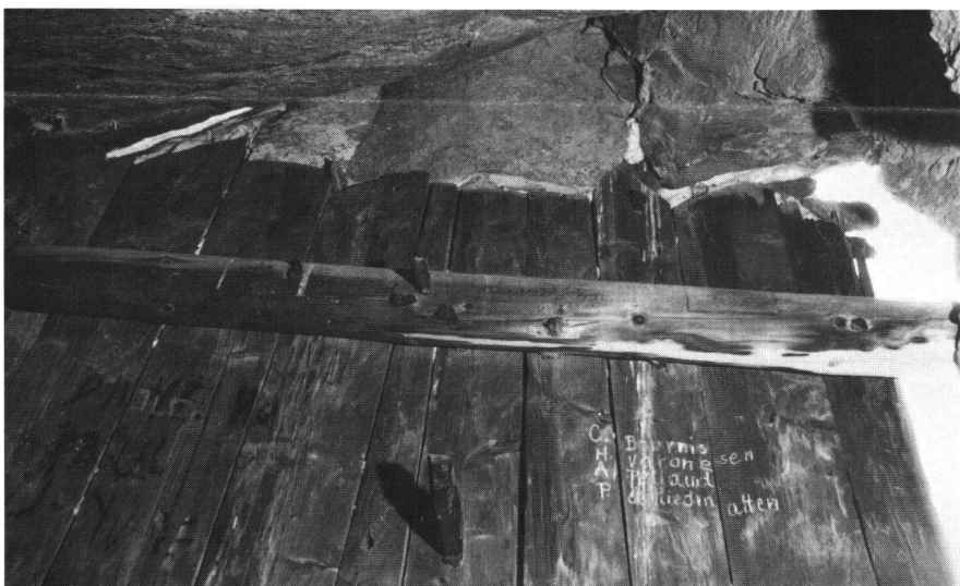
Abb.10 Hérémente VS, grotte aux fées. Verputzter hölzerner Bau, Innenansicht der talseitigen Wand und des Steinplattendaches. Die dritte Wandbohle von rechts ragt über das Dach hinaus, wo sie in einer Felspalte verkeilt ist.
